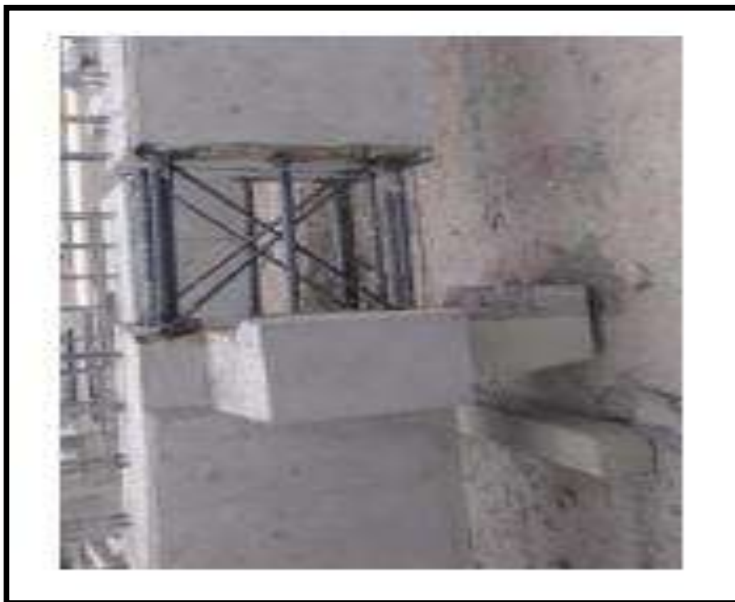
Figura N°27; Zona de cajon para nudo en columna cuadrada.
