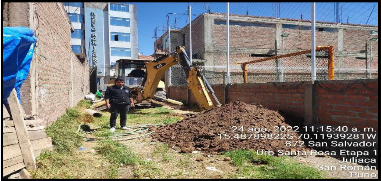
Figura N°05; realización de calicatas con maquinaria pesada retroexcavadora.
