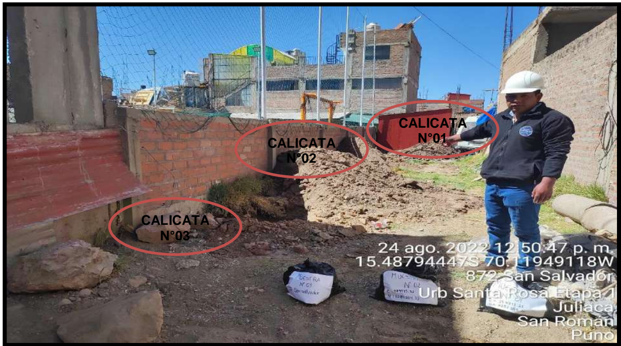
Figura N°07; extracción de muestra de las 03 calicatas realizadas.
