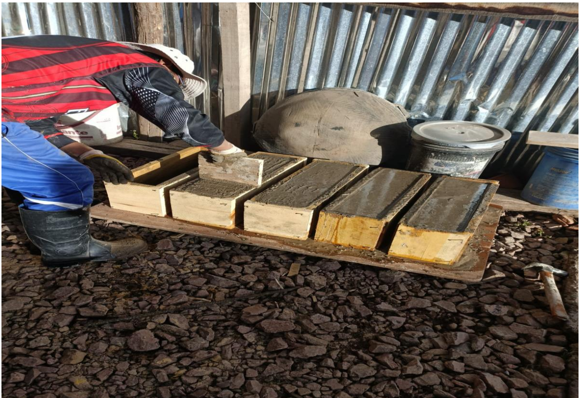
Foto 22: Vaciado del concreto en los sobrecimientos
