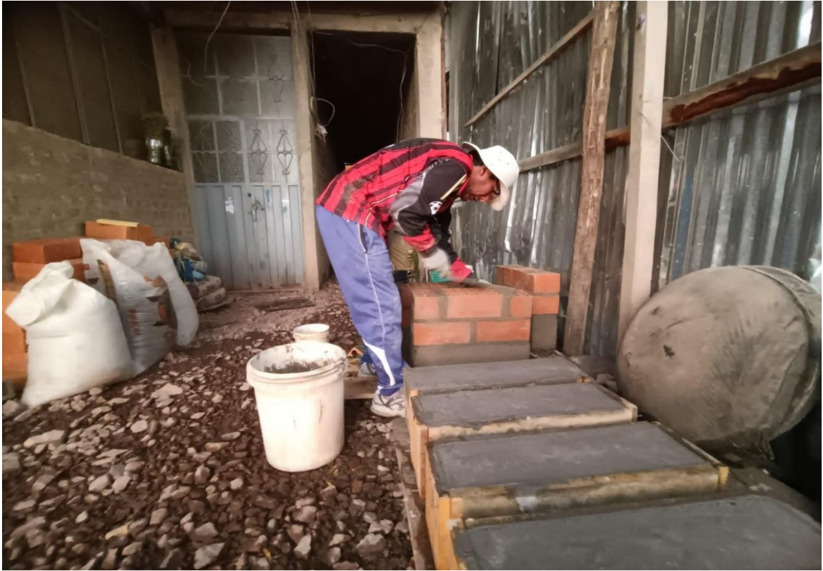
Foto 23: Asentado del ladrillo de los muros a escala
