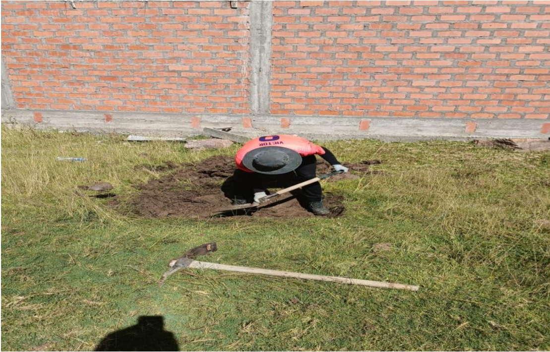
Foto 3: Excavación de la calicata para obtener la muestra representativa para los respectivos ensayos
