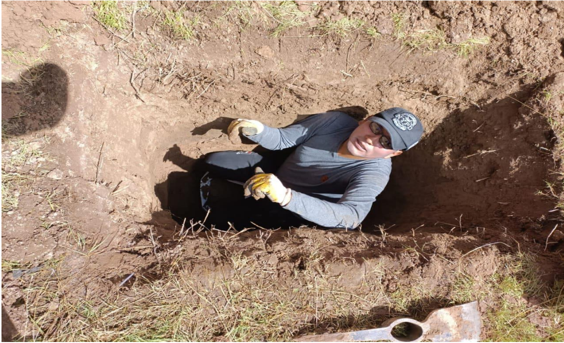
Foto 5: Termino de la excavación de la calicata para obtener el material para los ensayos de laboratorio.
