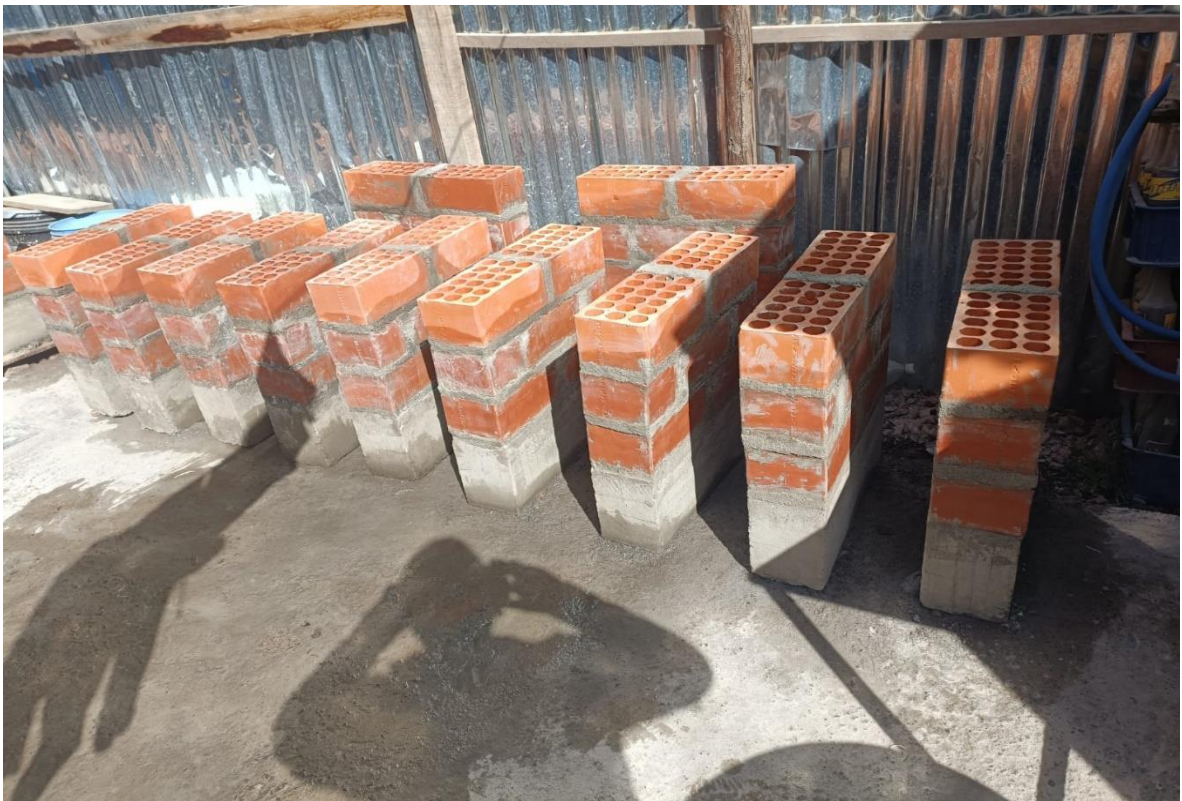
Foto 26: Muros a escala
