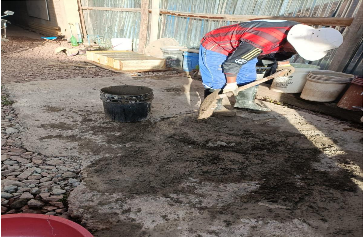
Foto 21: Preparación de la mezcla para los sobrecimientos con dosificaciones de 210kg/cm 2
