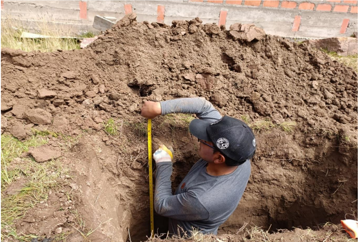
Foto 7: Finalización de la excavación de 1.50m de profundidad
