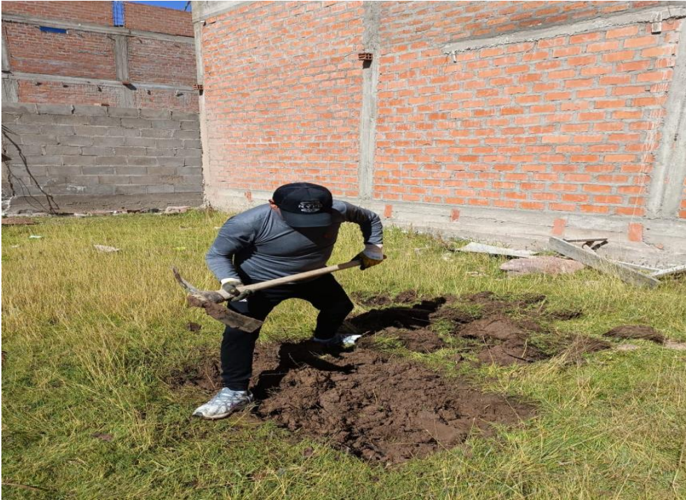
Foto 1: Excavación de la Calicata para obtener los ensayos respectivos
