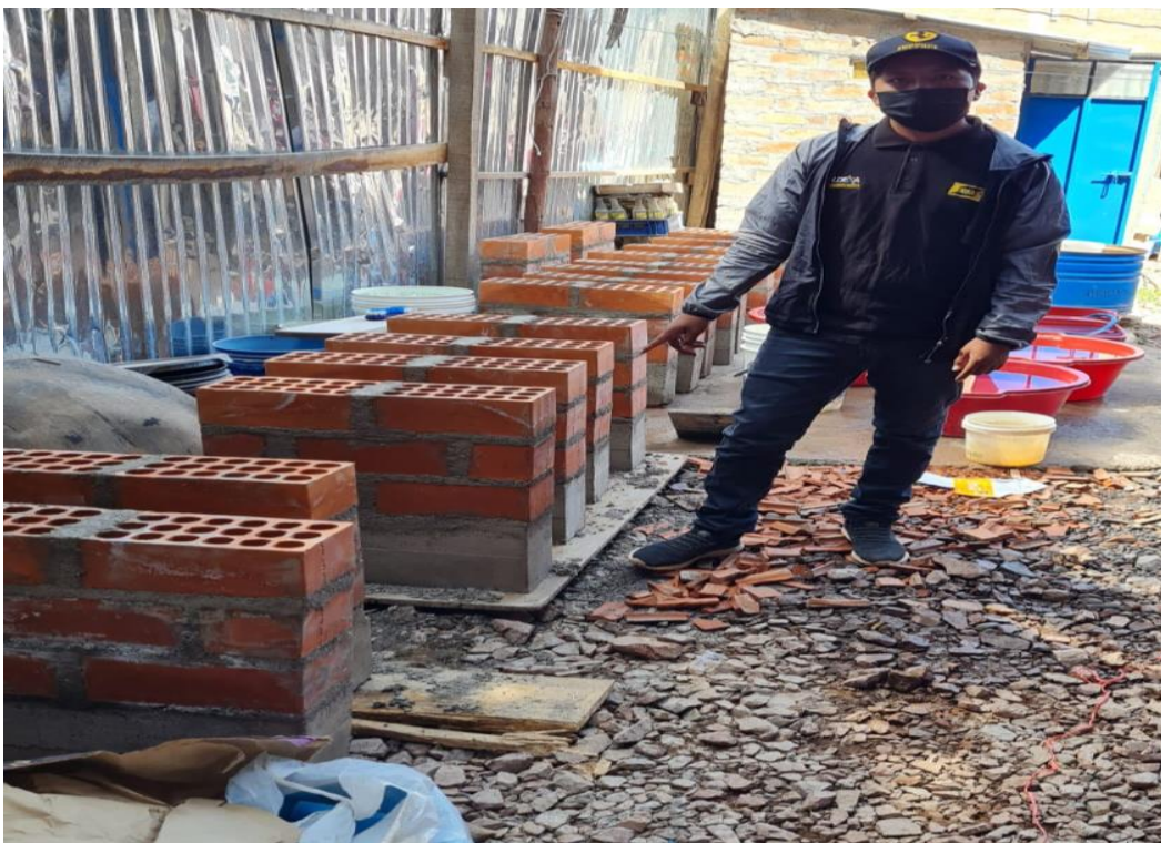
Foto 30: Muros a escala
