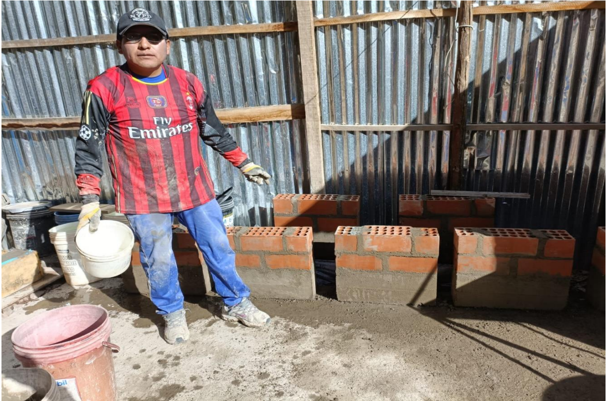
Foto 25: Asentado del ladrillo en los muros a escala
