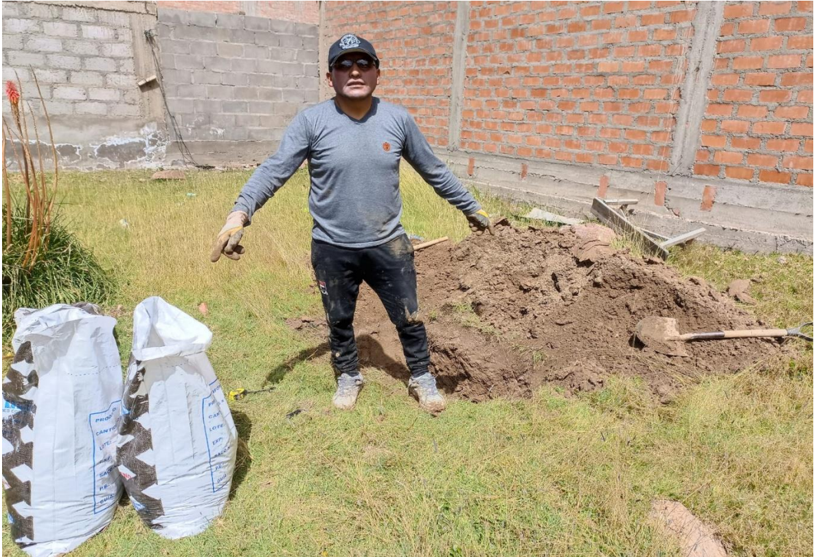
Foto 9: Extracción del material de la calicata para los ensayos de laboratorio
