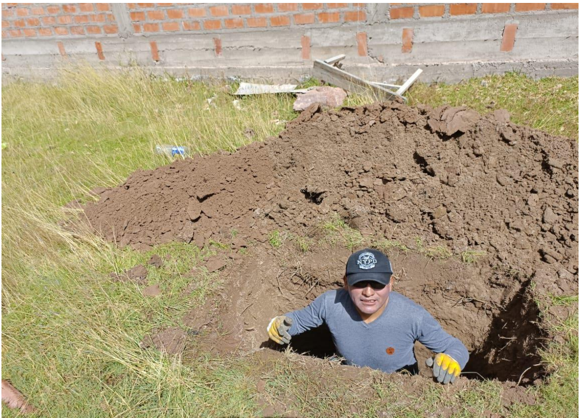
Foto 6: Finalización de la excavación de las calicatas
