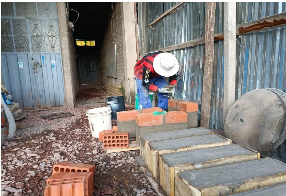
Foto 24: Asentado del ladrillo de los muros a escala
