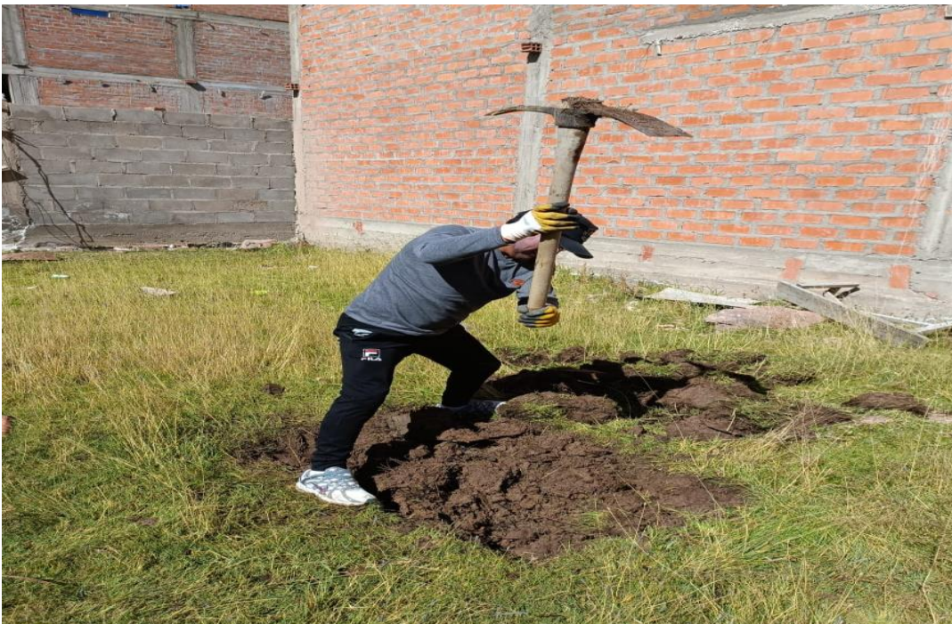
Foto 2: Excavación de la Calicata para obtener los ensayos respectivos
