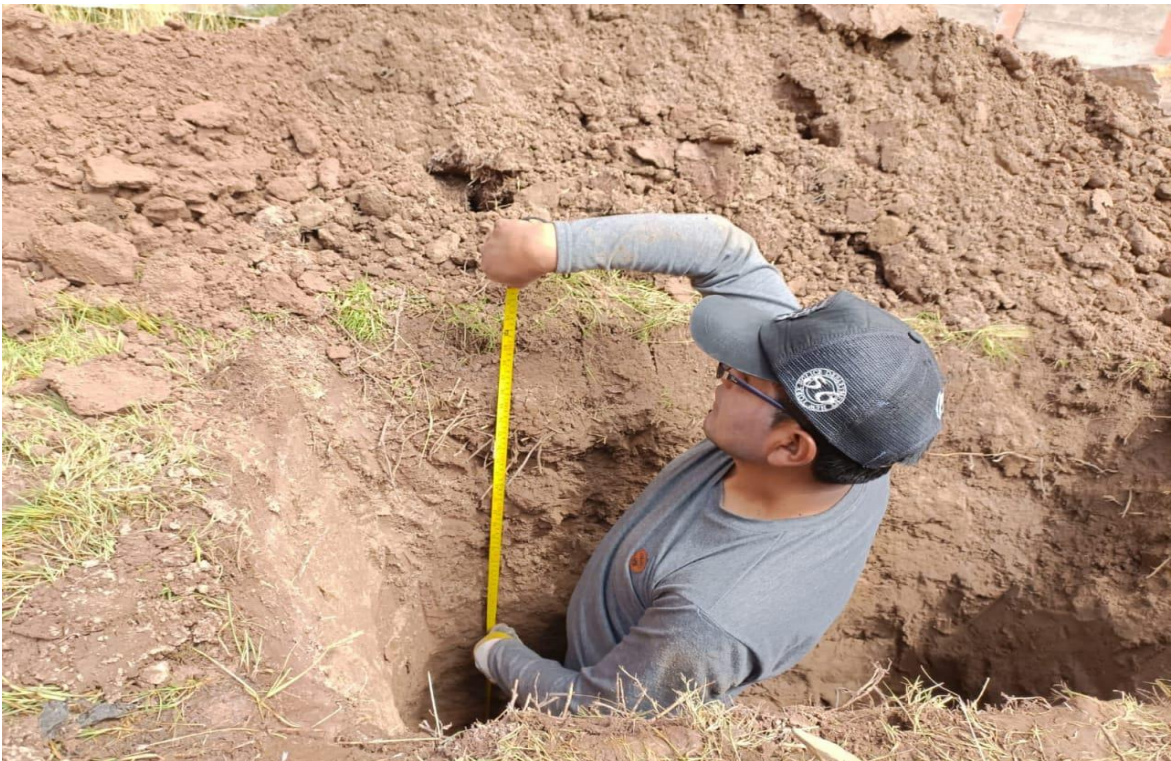
Foto 4: Remoción del material orgánico contaminado de 0.30m
