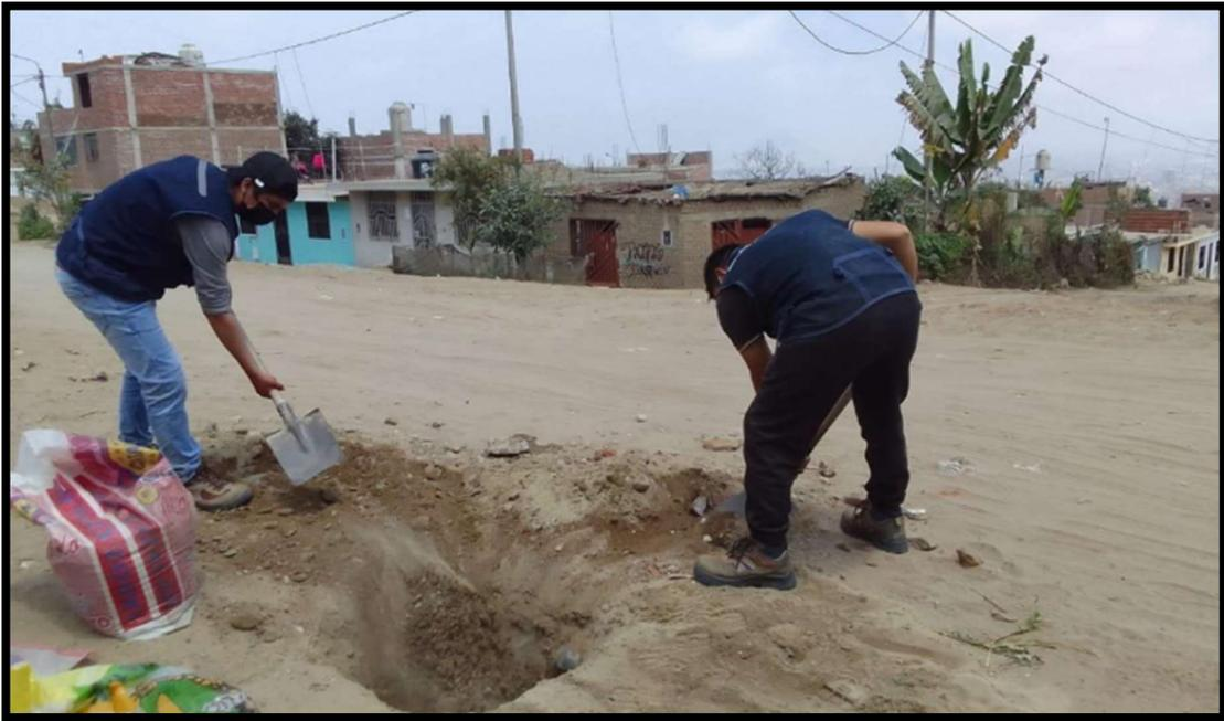
Imagen 5. Excavación de la calicata PC 01 de un metro cuadrado de ancho y 2.00 metros de profundidad.
