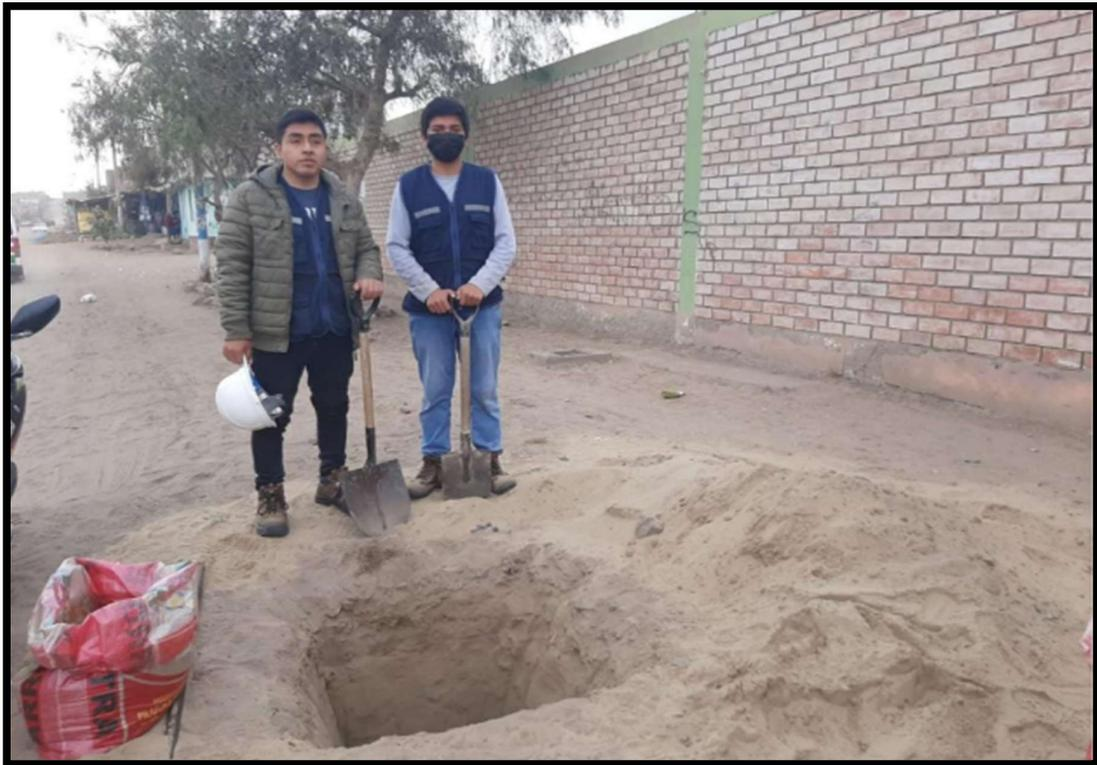
Imagen 6. Terminando de realizar la excavación de la calicata PC 06, de un metro cuadrado de ancho y 2.00 metros de profundidad.
