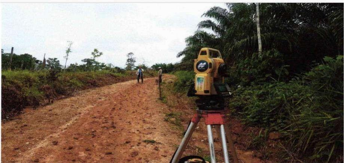
Anexo 40. Vista del equipo topográfico instalado
