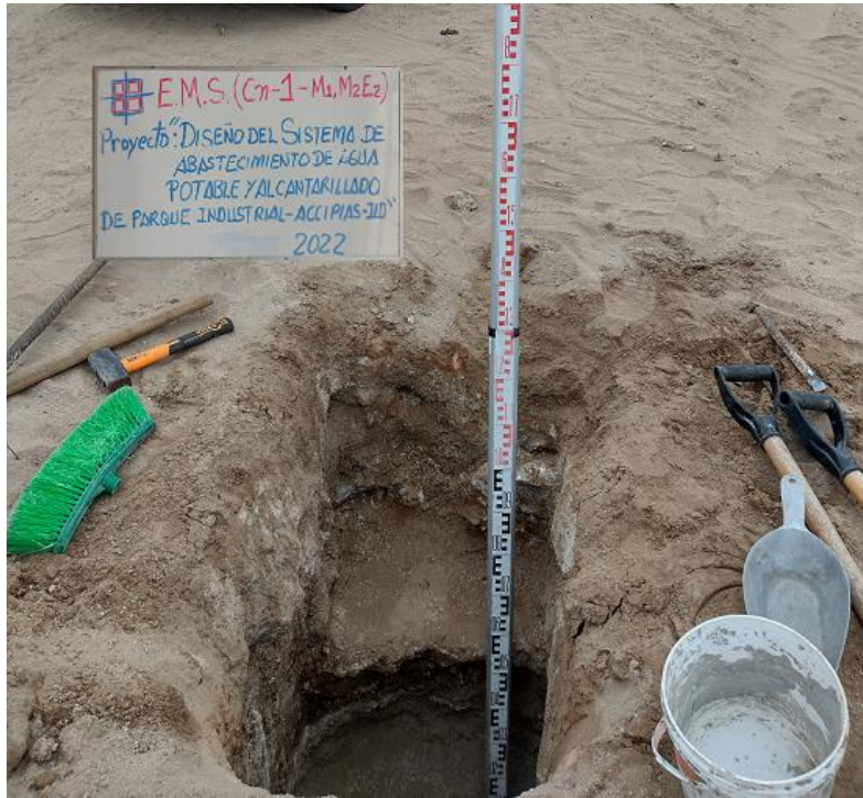
MEDICION DE PROFUNDIDAD DE EXCAVACION DE CALICATA Nº1
