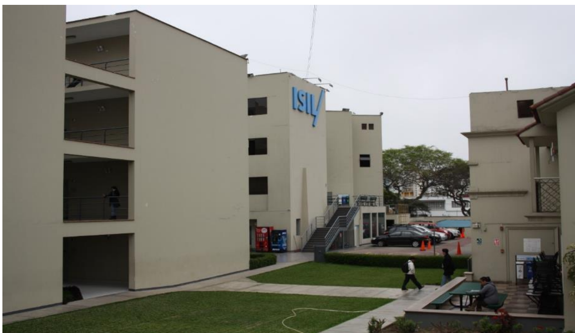
FIGURA N° 11: Fotografía de fachada del instituto ISIL en San Isidro
