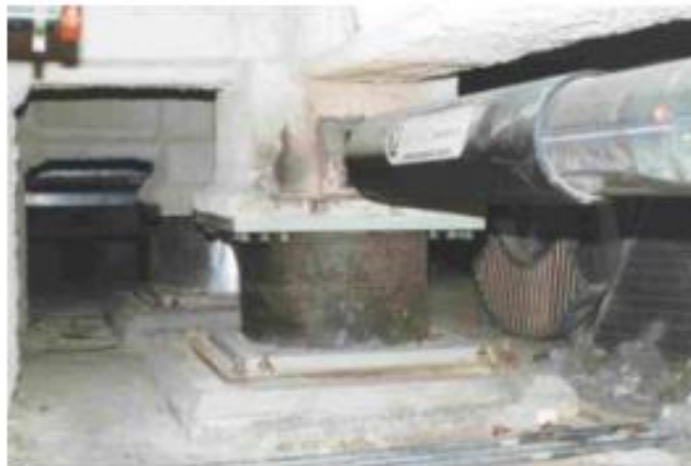
Aislador LDRB conectado a un amortiguador (Syman's)
