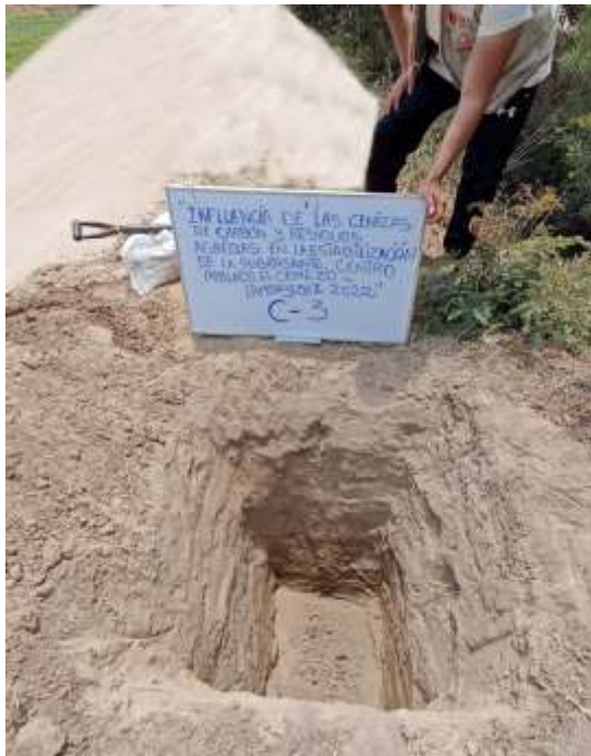
Foto 4: Excavación calicata 03
