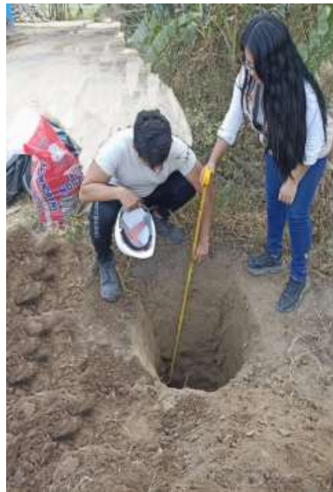
Foto 2: Trabajos de excavación
