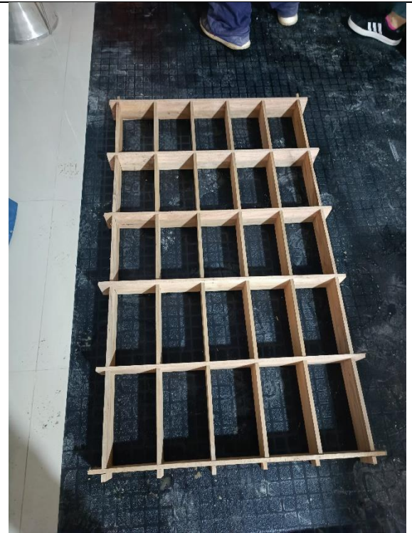
Foto N° 08: Encofrado para las unidades de albañería de concreto.
