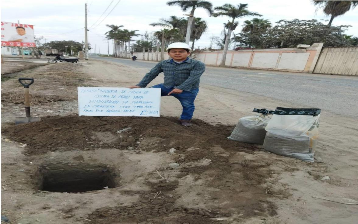
Figura 3. Excavacion de la calica N°1 en la progresiva 0+150 m
