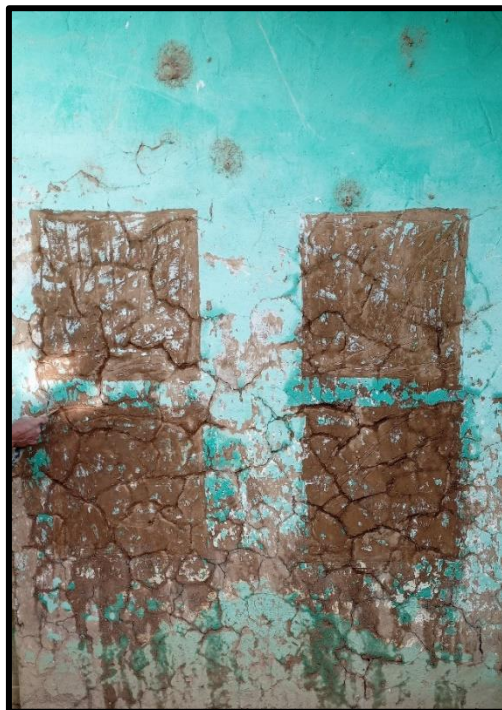
Figura 49: Delimitación y preparación de zonas para prueba de retracción.
