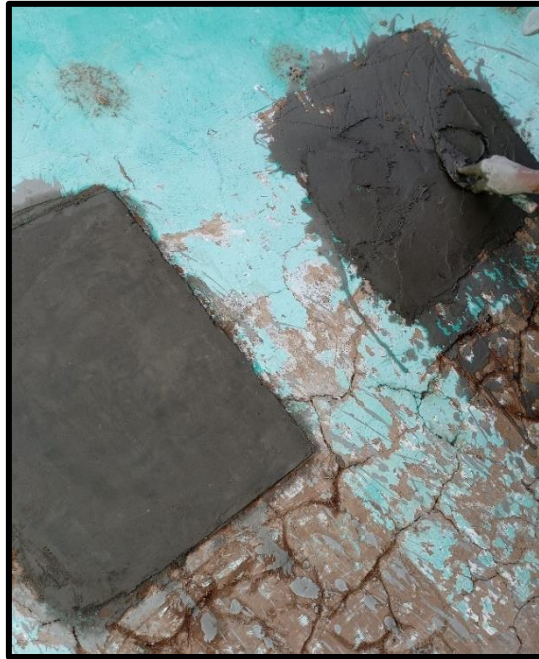
Figura 50: Tarrajeo de zonas para prueba de retracción
