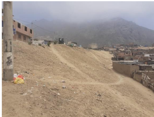
Figura 1. Talud en estudio - AA. HH. Pedro Ordoñez Lindo del Centro Poblado Alto Trujillo.
