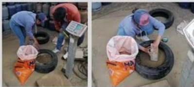
COLOCACIÓN DE TAPA DE CARTÓN, VACEADO Y COMPACTADO DE ARENA
