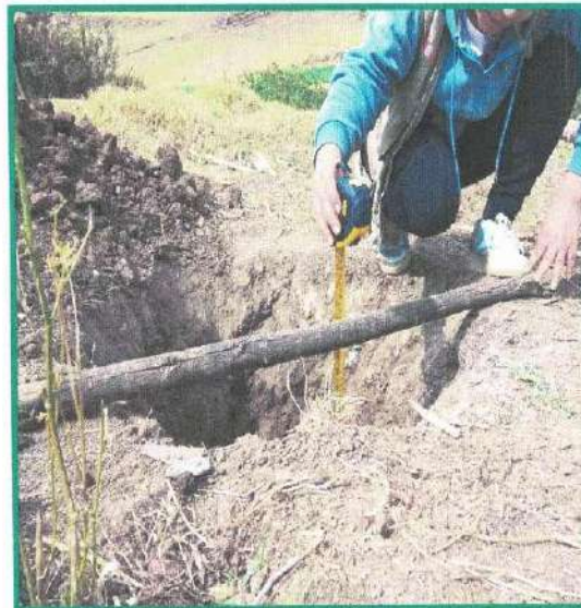
Imagen 10: se verifica la profundidad de la calicata C-04.
