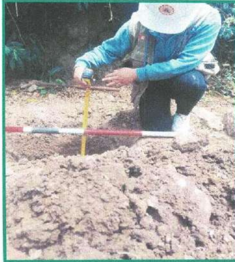
Imagen 03: se verifica la profundidad de la excavacion de la calicata C-01.
