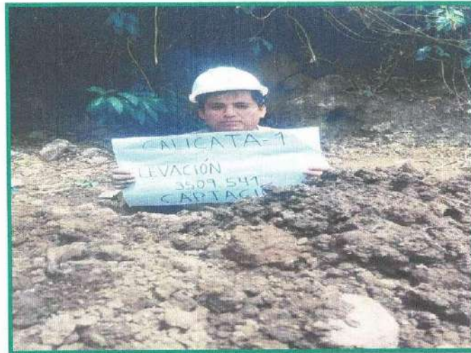
Imagen 04: se verifica la profundidad de la excavacion de la calicata C-01.
