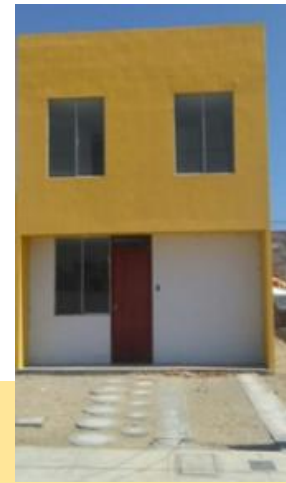
FUENTE: Imagen frontal I del Módulo de Vivienda Tipología II.
