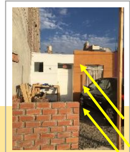
Iluminación directa en el espacio semipúblico.
