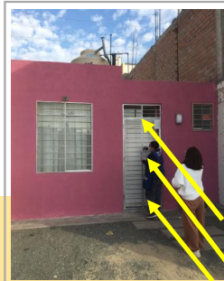
Iluminación directa en el espacio semipúblico.
