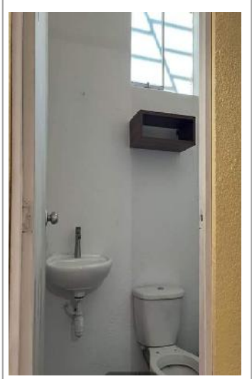
FUENTE: Imagen del Servicio Higiénico del Módulo Básico de Vivienda Tipología II.
