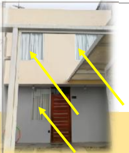
Iluminación directa en el espacio semipúblico.
