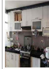
FUENTE: Imagen de la cocina del Módulo Básico de Vivienda Tipología II.
