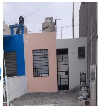
FUENTE: Imagen frontal I del Módulo de Vivienda Tipología II.
