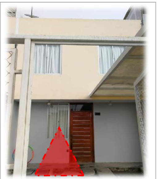
FUENTE: Imagen del fachada del Módulo Básico de Vivienda Tipología 3.
