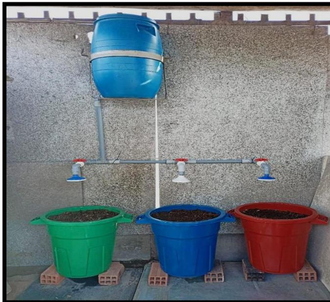
**Figura 5.** Instalación de tanque de almacenamiento y biofiltros
