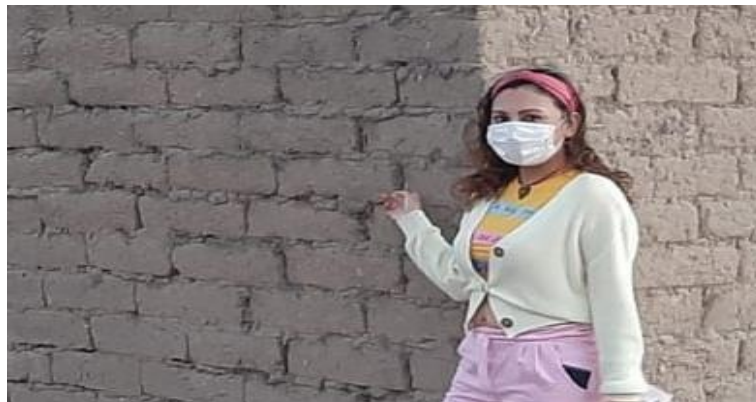
Figura 5: Piezas de adobe en aparejo creando las paredes de viviendas. Fuente: Elaboración propia
