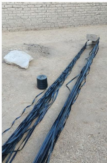
Preparación y pesado de materia prima, para incorporación al adobe convencional.
