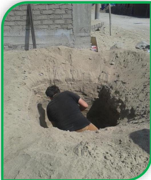
*Foto n°06: Se visualiza a nuestro colaborador de apoyo continuando con el trabajo de excavación de la Cn°01.*
