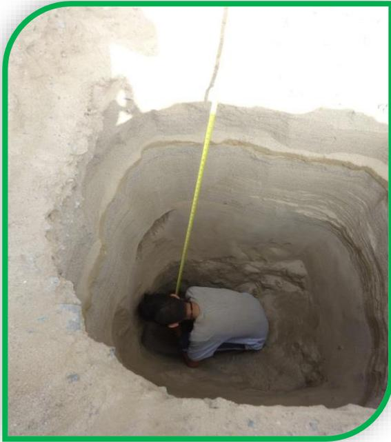
**Foto n°10:** Se visualiza a nuestros colaboradores midiendo la profundidad de la Cn° 01 donde en el proceso de excavación se encontró favorablemente una superficie rocosa a los 3.40 m de profundidad.
