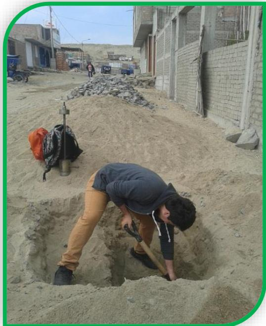
*Foto n°05: Se visualiza a nuestro colaborador de apoyo continuando con el trabajo de excavación de la Cn°01.*
