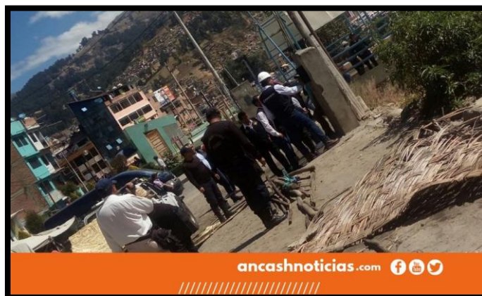
Fig.7: Inspección de la municipalidad en derrumbe de una vivienda informal. Fuente: Ancash Noticias
