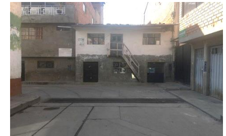
Pista pavimentada de 3.4 de ancho, con veredas de 0.50 cm de ancho.
