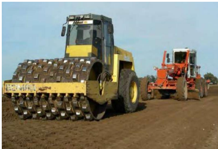
Figura 4. Estabilización por compactación usando un rodillo “pata de cabra”.
