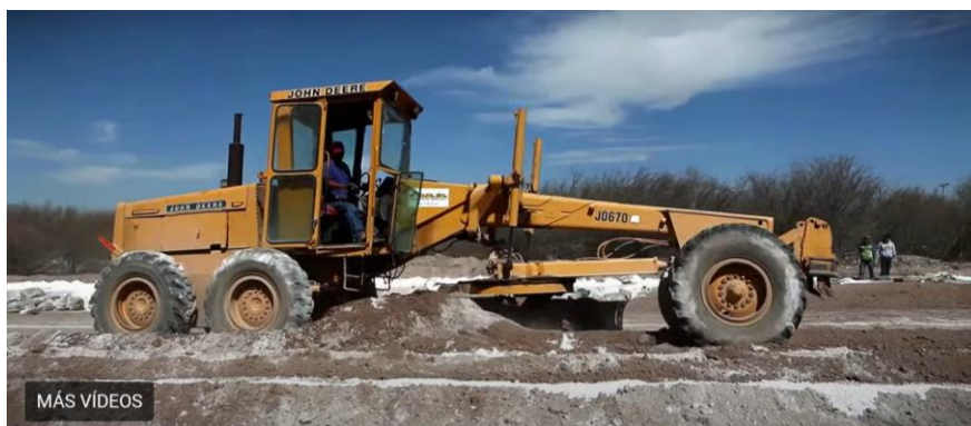
Figura 5. Estabilización del suelo con Cal.
