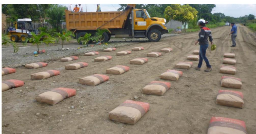
Figura 6. Estabilización del suelo con Cemento.
