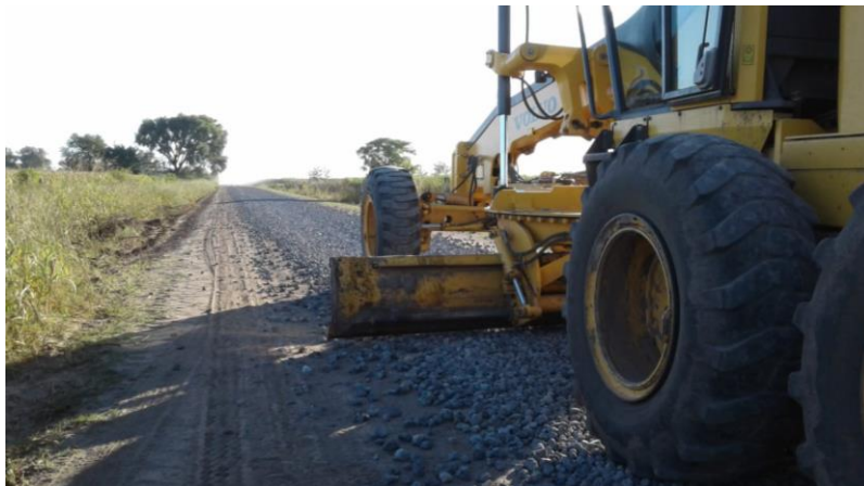
Figura 9. Estabilización con escoria.
