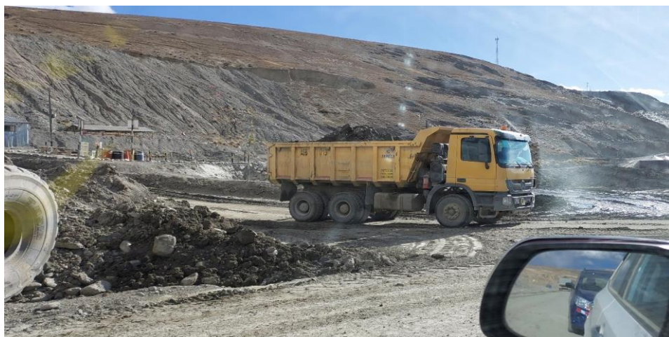
Trasporte del DMG a zonas aledañas del tramo Pampa Blanca-Rinconada
