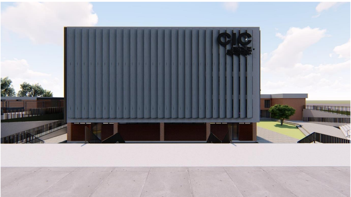
Figura 63 Vista Fachada Frontal
