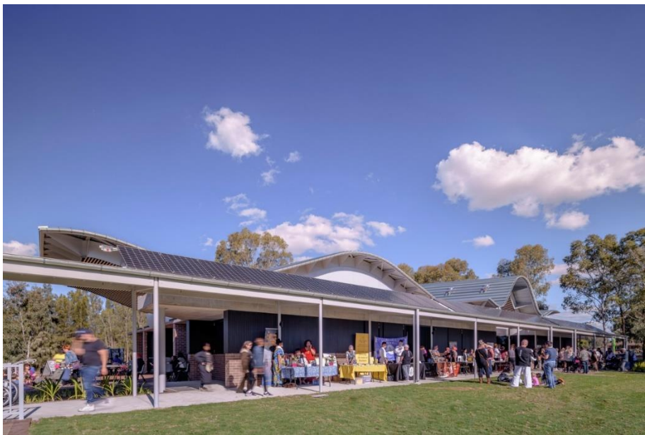
Fachada lateral Centro Comunitario Woodcroft
