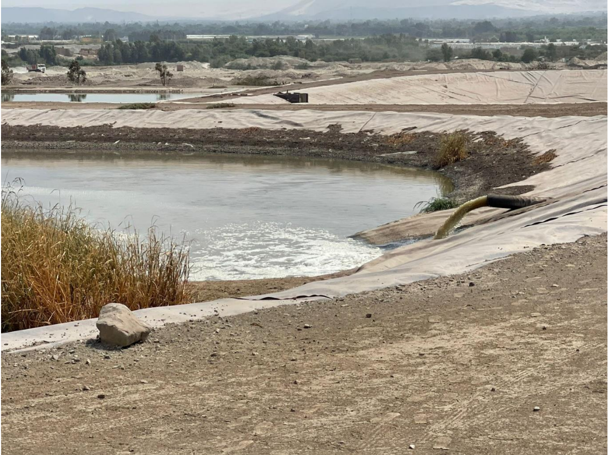
En la figura se visualiza la vista exterior de la laguna de oxidación “Yaurilla” dentro del departamento de Ica.
