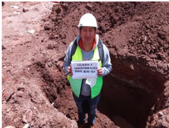
C-1, Progresiva 0+000.00 Km
