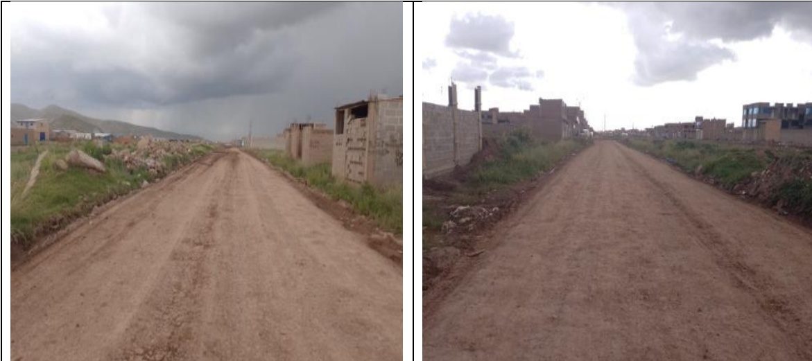
Progresiva 01+500.00 KM (VIA JULIACA – ISLA)
