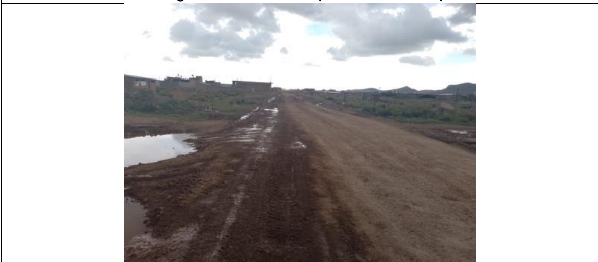
Progresiva 02+000.00 KM (VIA JULIACA – ISLA)
