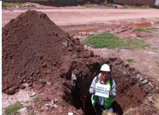
C-3, Progresiva 1+400.00 Km
