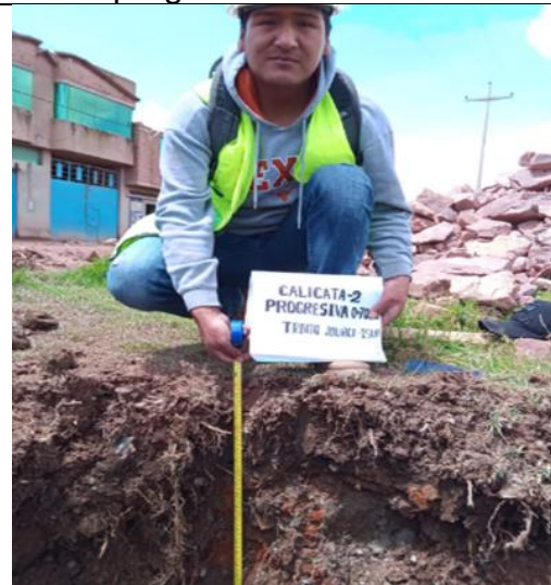
C-2, Progresiva 0+700.00 Km
