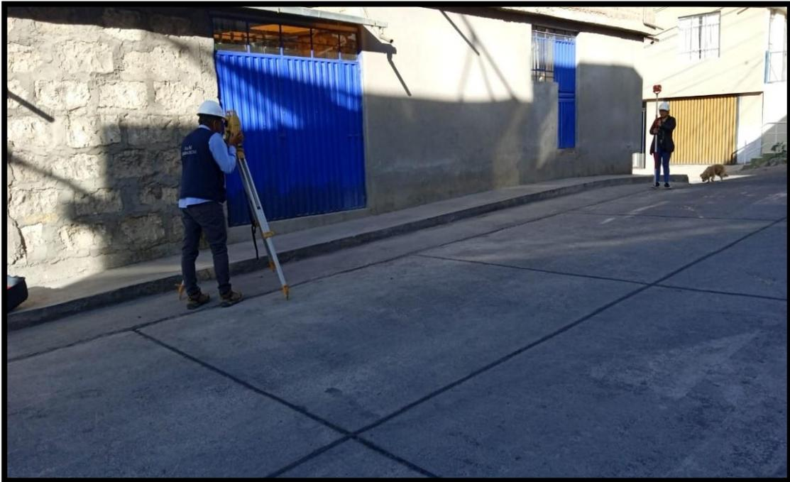
Foto N°01: En la toma fotográfica se puede apreciar el levantamiento topográfico de la Calle José de San Martín – Atahualpa – N°1 – Jacobo Hunter
