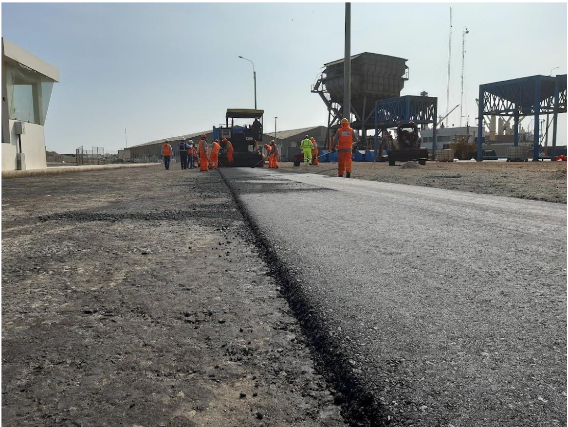
Imagen pavimentación puerto Salaverry.
