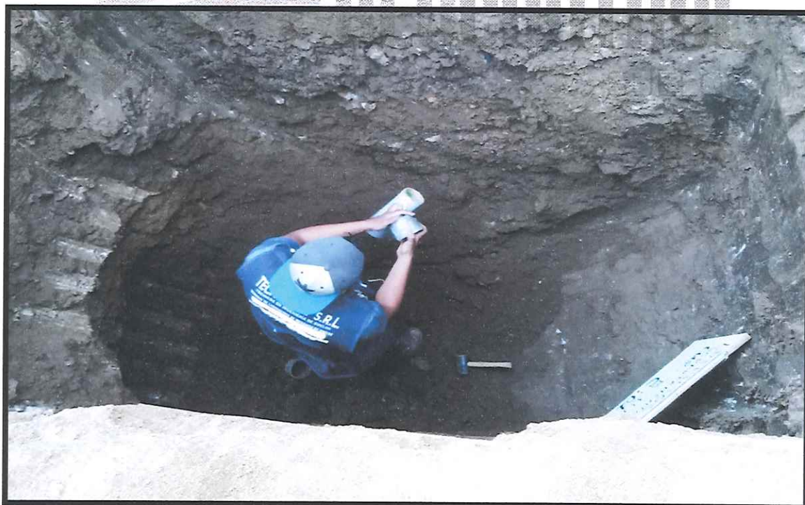
EXTRACCION DE LA MUESTRA INALTERADA PARA EL ENSAYO DE CORTE DIRECTO DE LA C- 01
