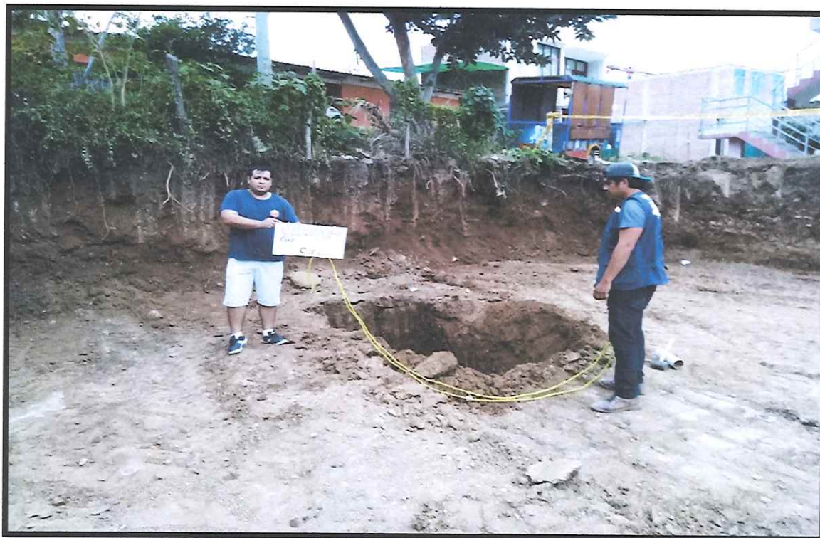
VISTA PANORAMICA DE LA CALICATA N° 02
