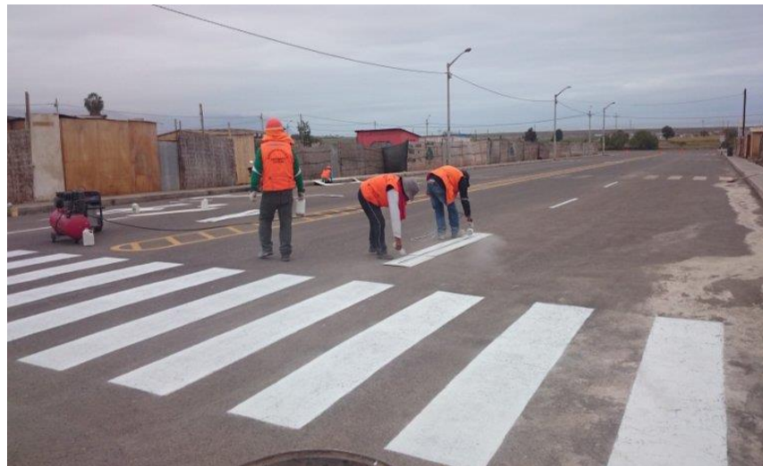
Figura 7. Mantenimiento de pistas (Ingeindustria Consultores P&G SCRL, 2020)
