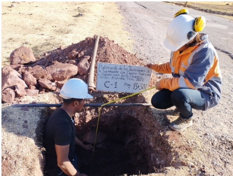
Figura 1 Calicata 1 extracción de muestras
