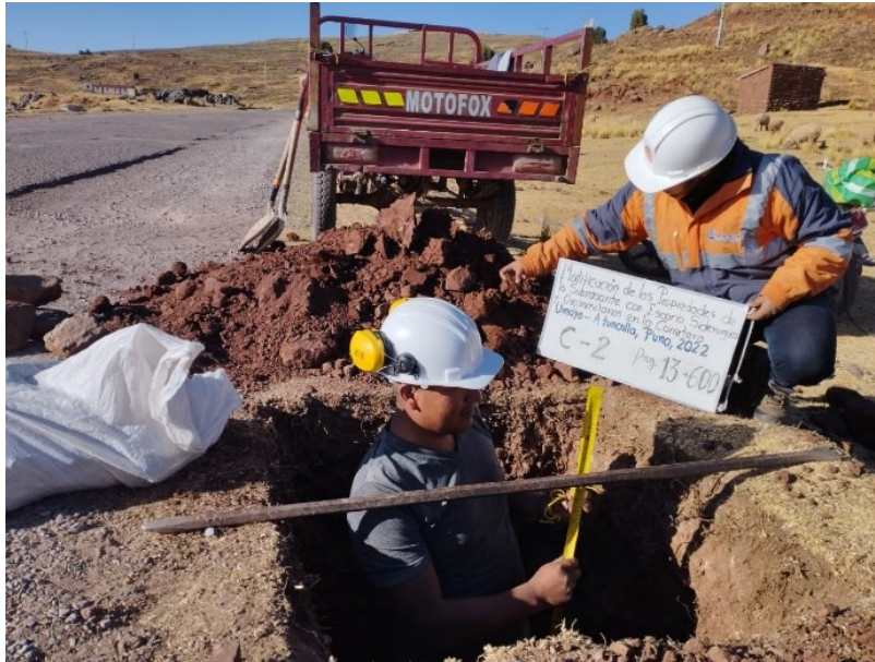
Figura 2 Calicata 2 extracción de muestras
