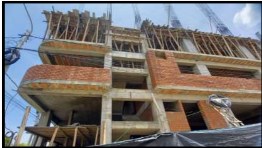
Figura N° 6: Fachada de la edificación
