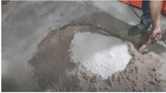
Foto 9: incorporación de cemento y ceniza de cáscara de café Fuente: Elaboración Propia
