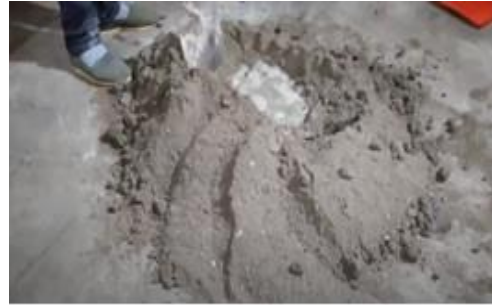
Foto 10: preparación de la mezcla para la elaboración del ladrillo Fuente: Elaboración Propia
