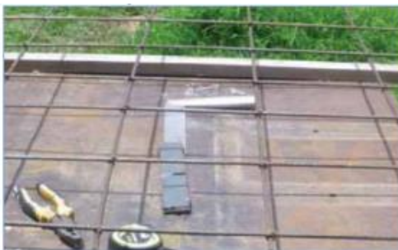
Figura 4. Armadura discreta
