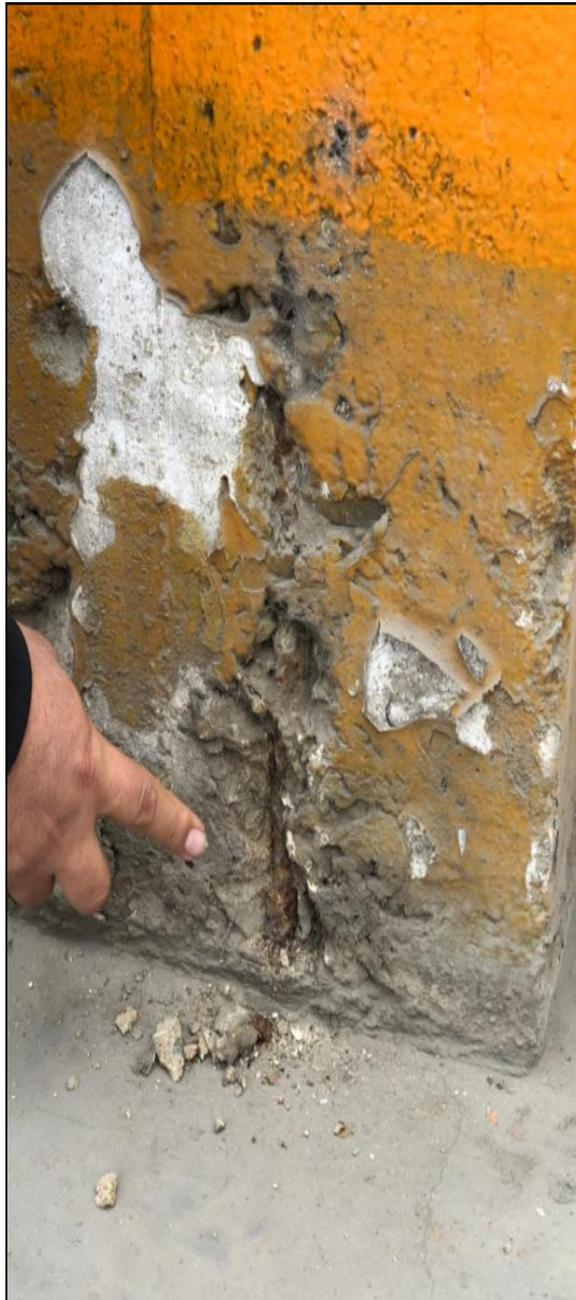
*Figura 16: Presencia de oxido en lacolumna. Fuente: Elaboración propia*
