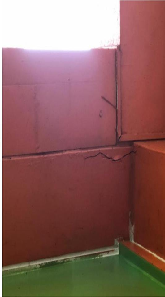
*Figura 18: Grietas en la estructura del hormigón. Fuente: Elaboración propia*
