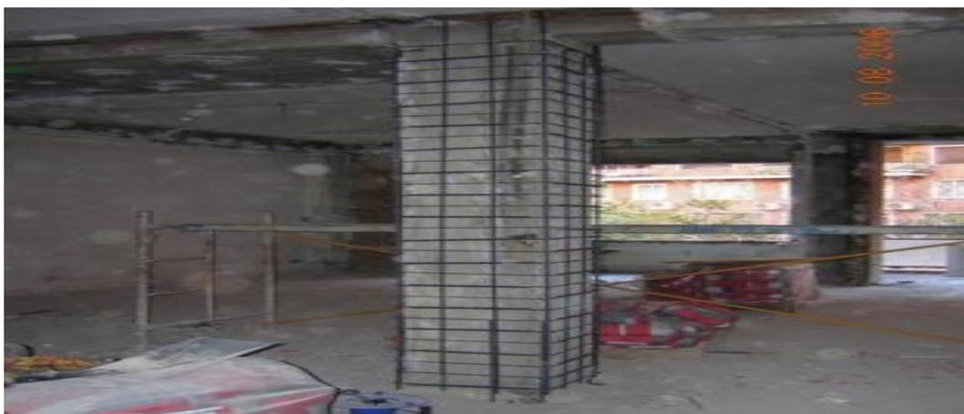
Figura 5: Encamizado de columna. Fuente 1: Internet
