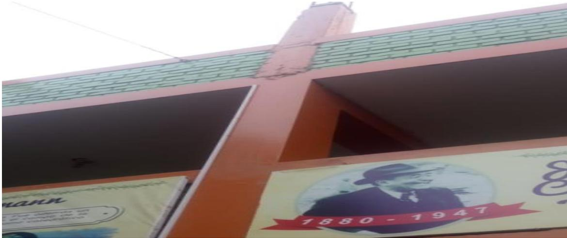
Figura 19: Columnas desfazadas en los niveles 2 y 3. Fuente: Elaboración propia
