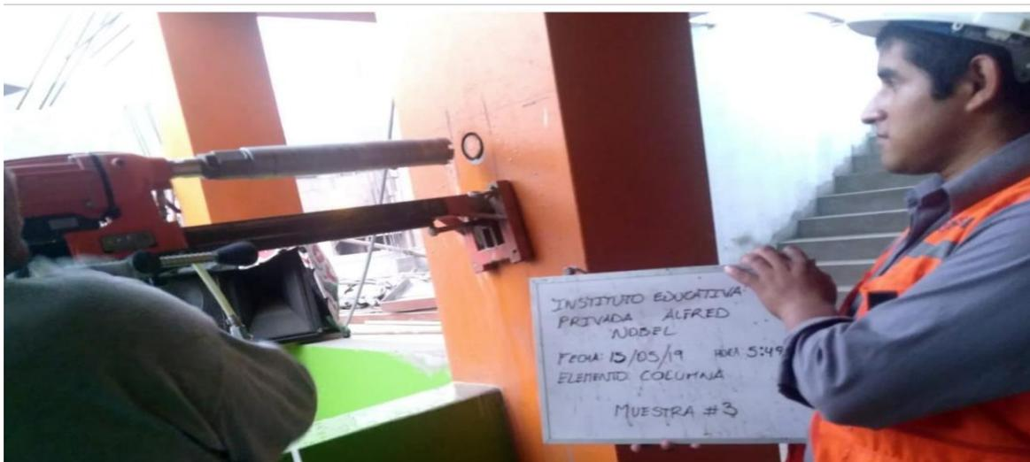
Figura 36: Proceso de extracción de muestra. Fuente: Elaboración propia
