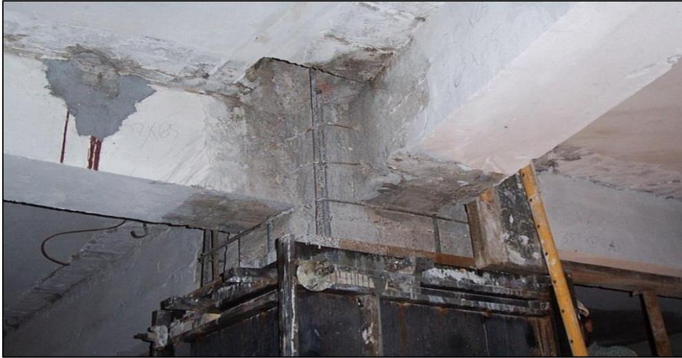
Figura 3: Encamizado de viga. Fuente: <https://epachon.wordpress.com/2014/01/16/e-4-refuerzo>
