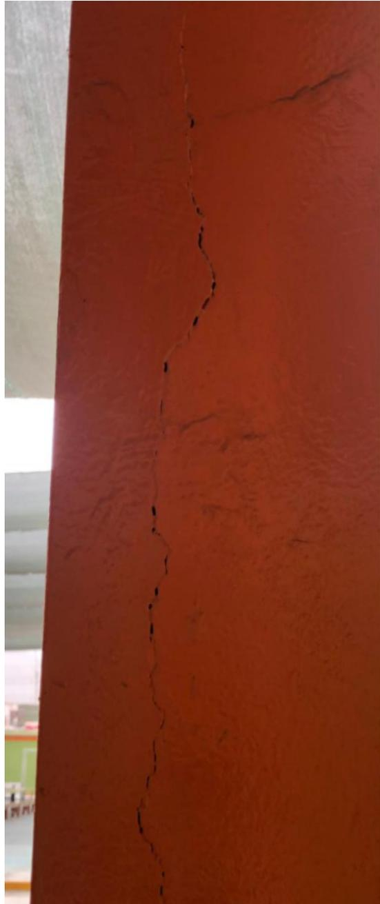
*Figura 15: Columna fisurada en el pabellón A: Fuente: Elaboración propia*
