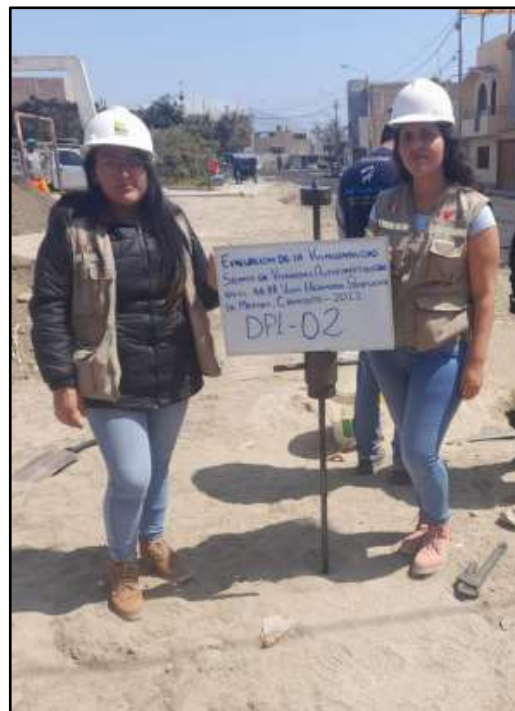
Fotografía 4. Realización de la auscultación DPL-02
