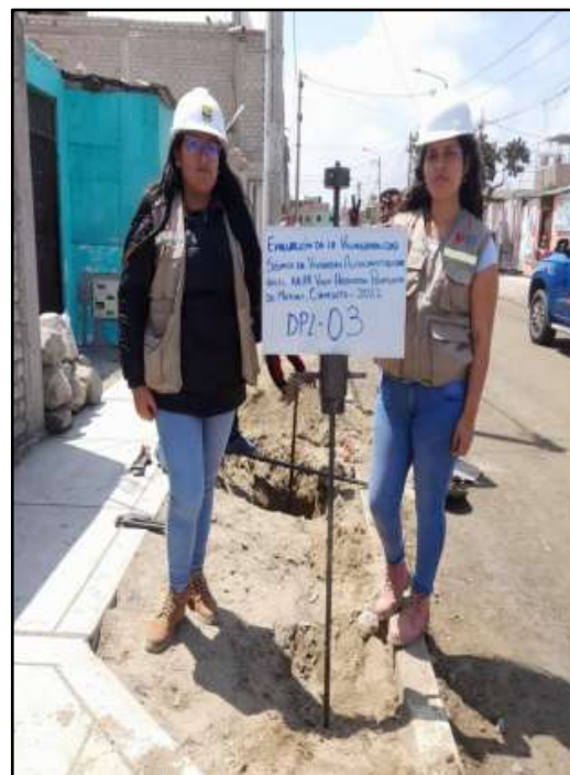
Fotografía 6. Realización de la auscultación DPL-03
