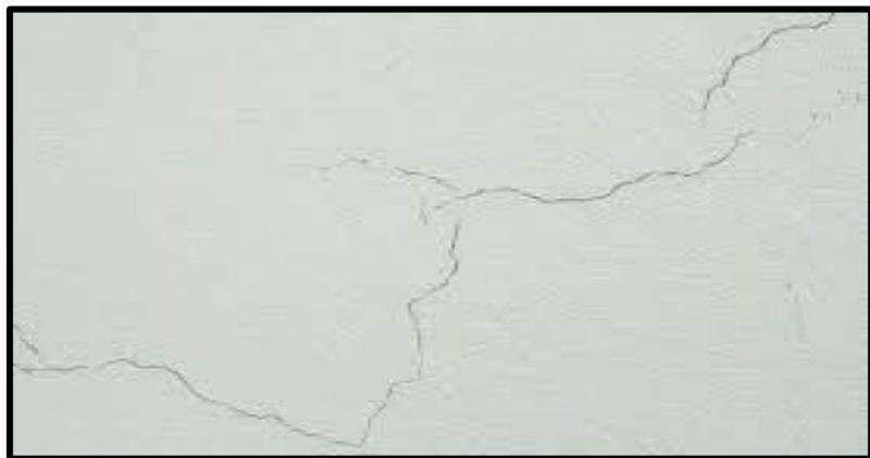
Ilustración 19: Fisuras en acabados.
