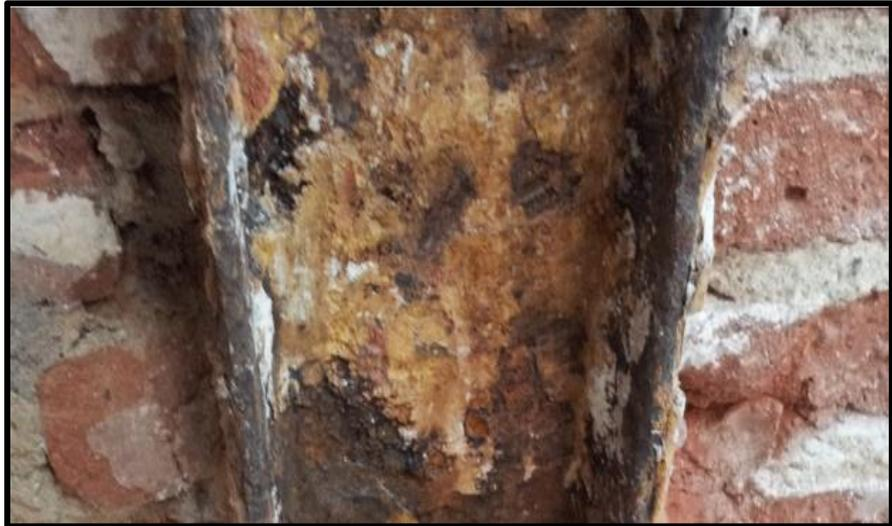
Ilustración 16: Oxidación y corrosión en el acero.
