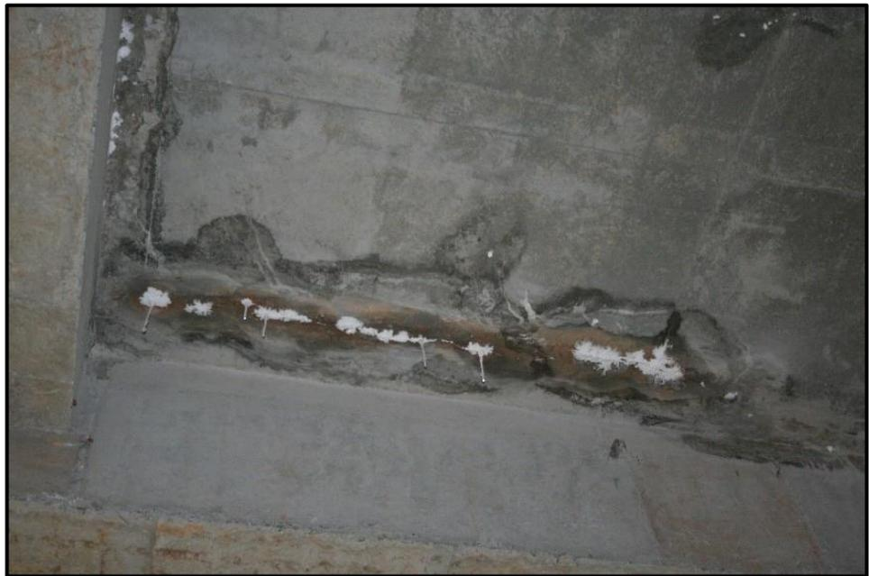
Ilustración 15: Eflorescencia en el concreto.
