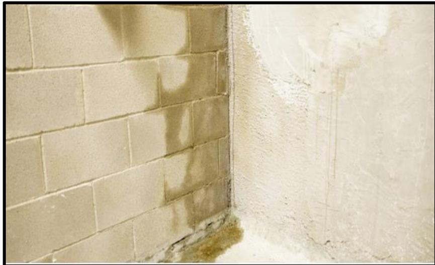
Ilustración 14: Daño estructural por la humedad.
