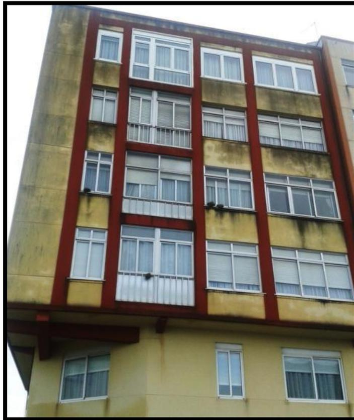
Ilustración 11: Suciedad causada por la contaminación del aire.
