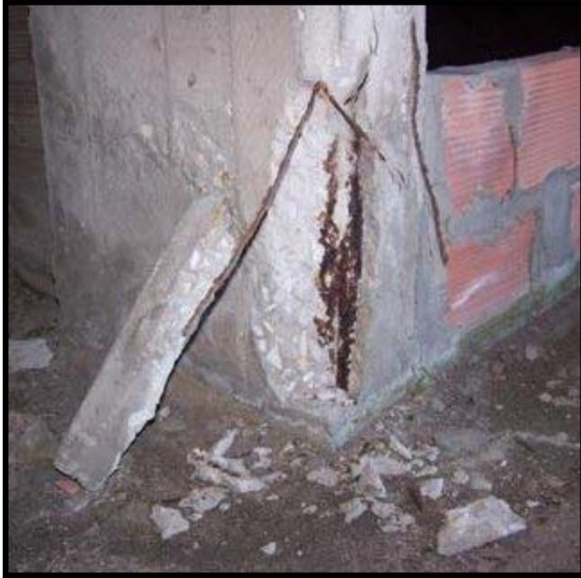
Ilustración 6: Corrosión del acero en columna.
