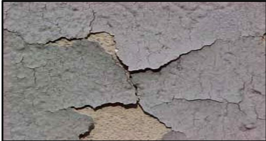
Ilustración 17: Desprendimiento en muro.
