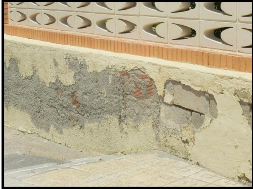
Ilustración 12: Erosión causada por agentes atmosféricos externos
