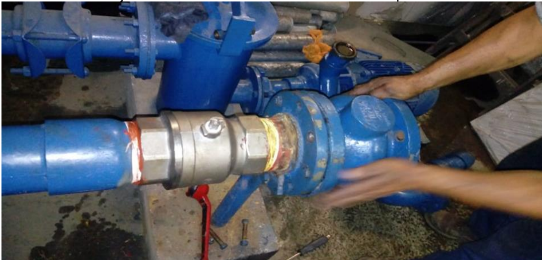
Desmontaje de válvula check.
