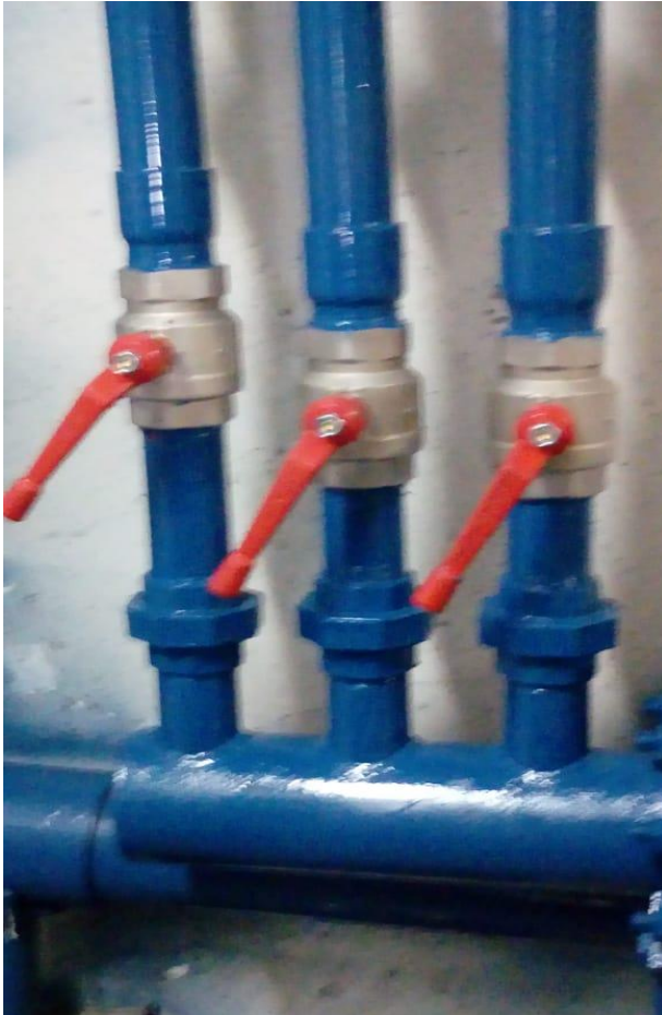
Se instalaron válvula y uniones universales en línea de impulsión.
