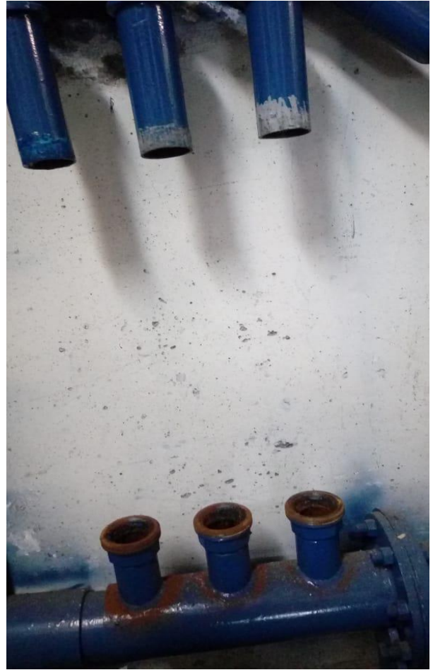
Retiro de 03 válvulas de paso, están obstruidas.
