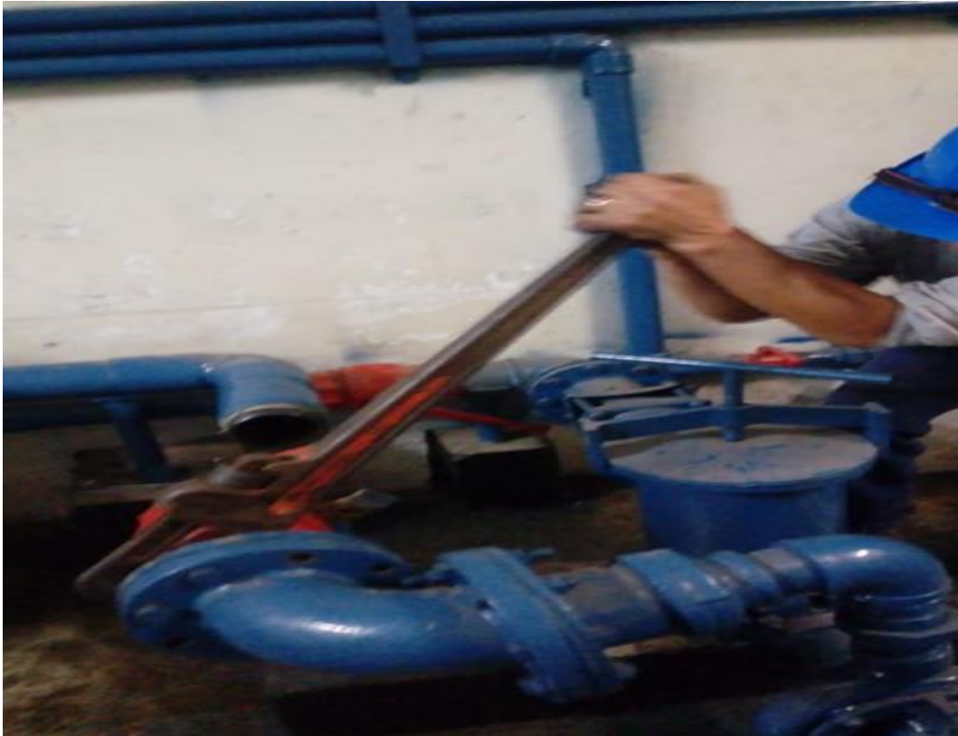
Desmontaje de válvula de bola, no cierra ni apertura.
