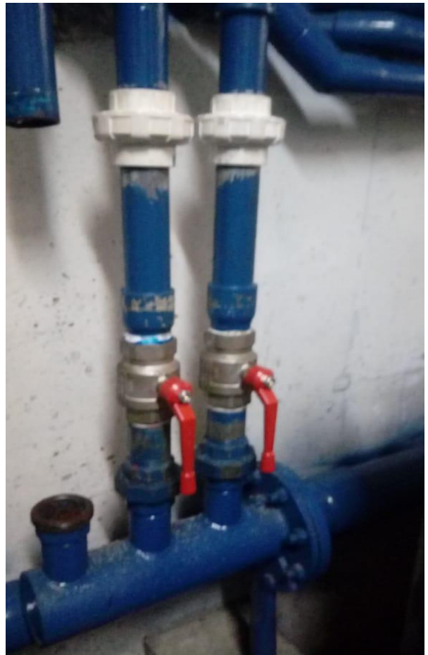
Se instalaron válvula y uniones universales en línea de impulsión.
