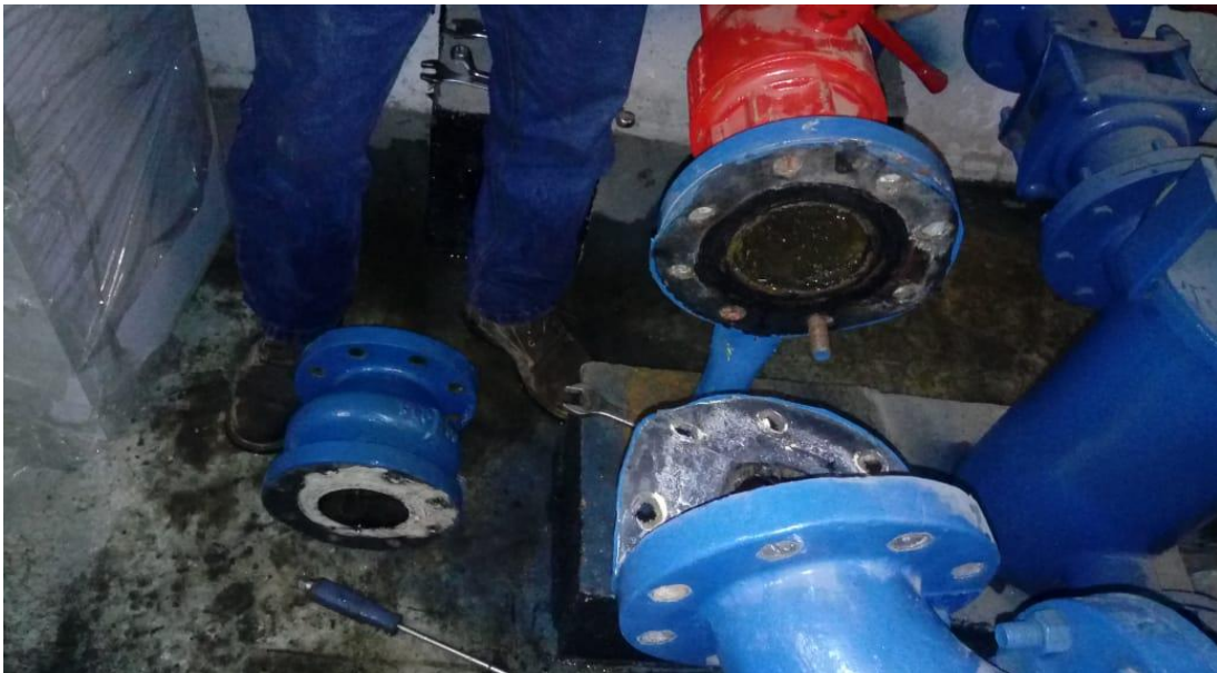
Desmontaje de válvula de bola, no cierra ni apertura.
