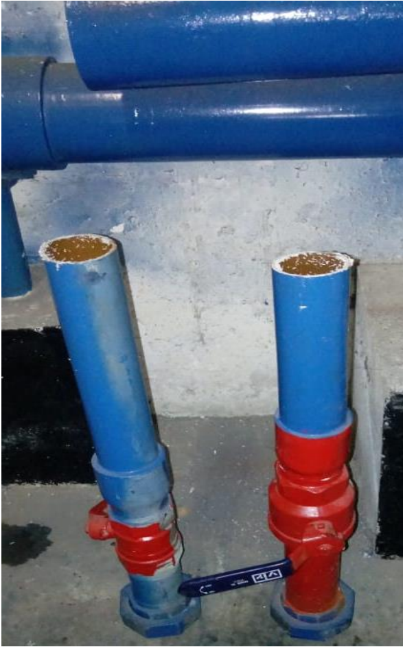
Retiro de 03 válvulas de paso, están obstruidas.
