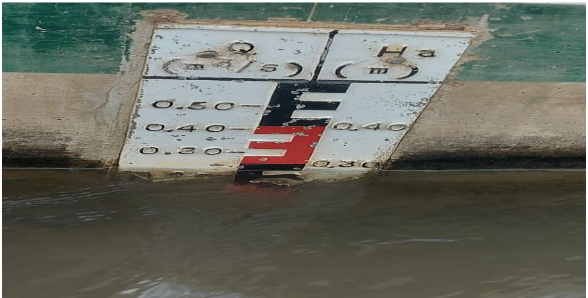
Foto N°4. Centro Poblado Mariscal Castilla: Canal Paco tramo Km 1+518 aforo de caudal máximo.
