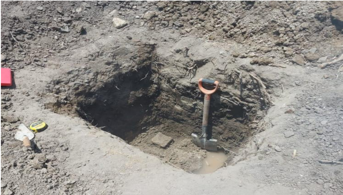
Foto N.º 3. Carretera Centro Poblado Puente Mayta: excavación de calicata N°12, coordenadas UTM X=676592.8306; Y=9193150.7088, septiembre – 2022.
