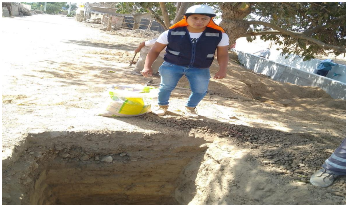
Foto N.º 2. Carretera Centro Poblado Puente Mayta: excavación de calicata N°8, coordenadas UTM X=676139.0262; Y=9195080.2119, septiembre – 2022.
