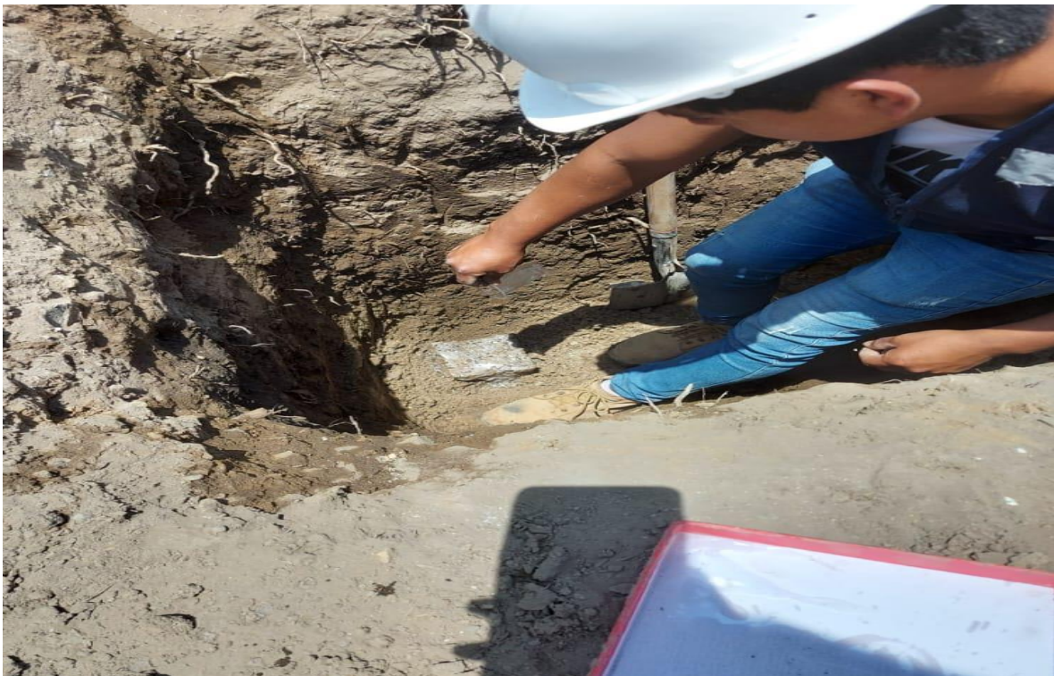
Foto N.º 4. Carretera Centro Poblado Puente Mayta: excavación de calicata N°14, coordenadas UTM X=677168.9420; Y=9192405.9819, septiembre – 2022.
