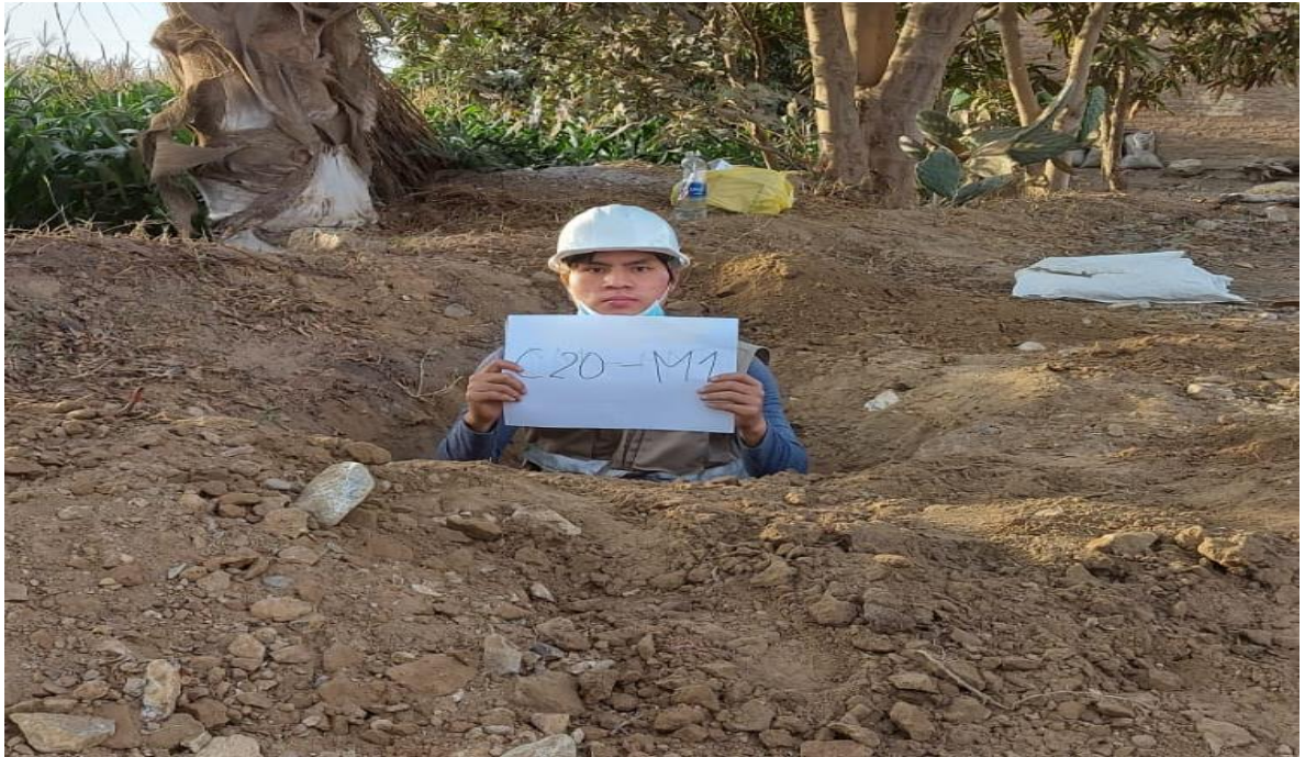
Foto N.º 9. Carretera Centro Poblado Mariscal Castilla: trazo para la excavación de calicata N°20 coordenadas UTM X=675801.1686; Y=9192658.0545, septiembre – 2022.
