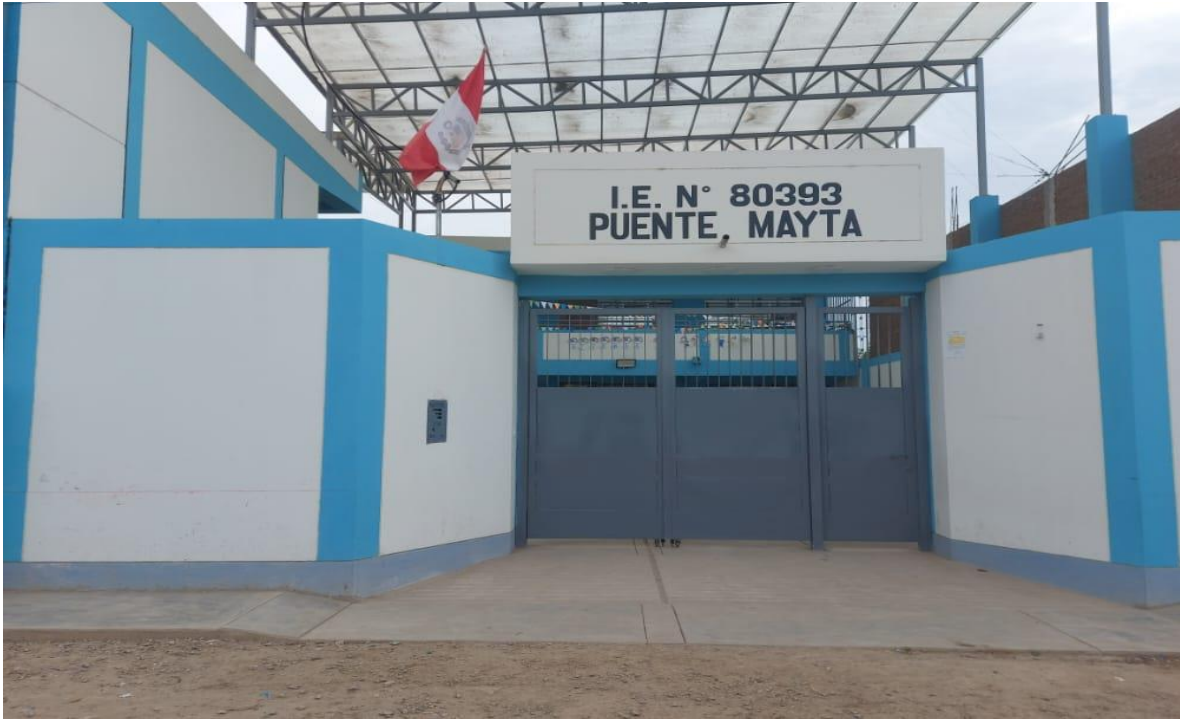
Foto N° 5. Centro Poblado Puente Mayta: Institución Educativa N° 80393 Puente Mayta Km 7+340 coordenadas UTM X= 677314.6467; Y= 9192209.7471; Z=147.06 msnm.
