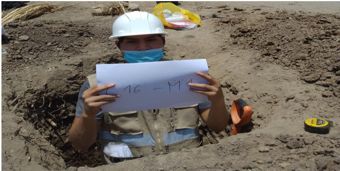
Foto N.º 6. Centro Poblado Puente Mayta: extracción de muestra para ser llevadas a laboratorio de calicata N°16, coordenadas UTM X=677894.2047; Y=9191947.9117, septiembre – 2022.
