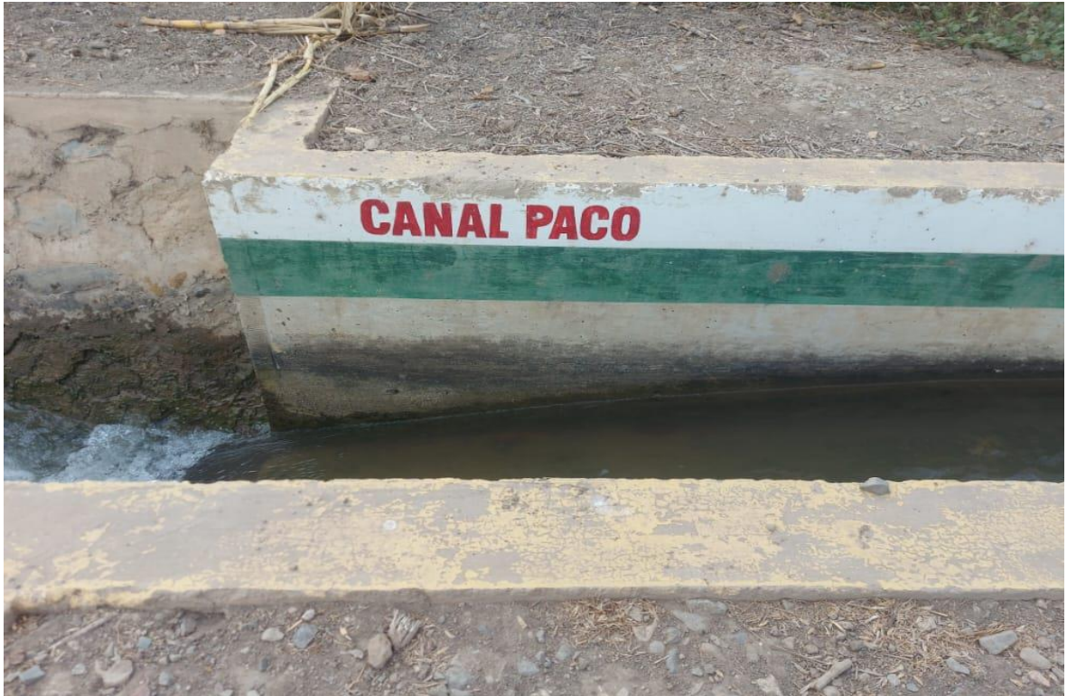
Foto N°3. Centro Poblado Mariscal Castilla: Canal Paco tramo Km 1+518
