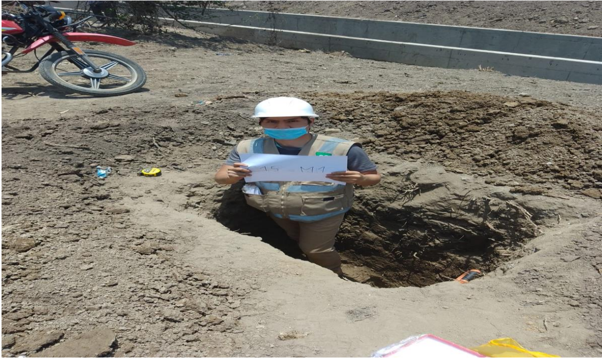
Foto N.º 5. Centro Poblado Puente Mayta: extracción de muestra para ser llevadas a laboratorio de calicata N°15, coordenadas UTM X=677515.0574; Y=9192061.2592, septiembre – 2022.
