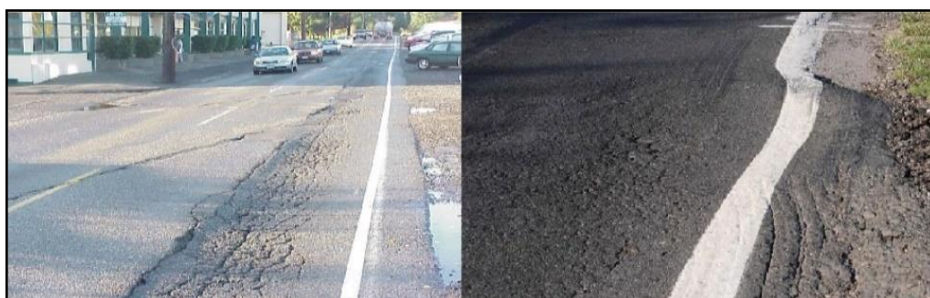
Figura 20. Ahuellamiento
