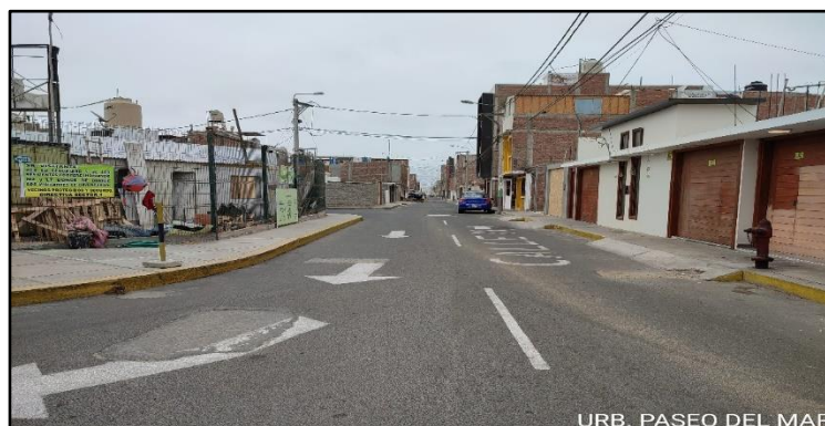
Figura 48. Pavimento flexible de la Urb. Paseo del Mar - Nuevo Chimbote
