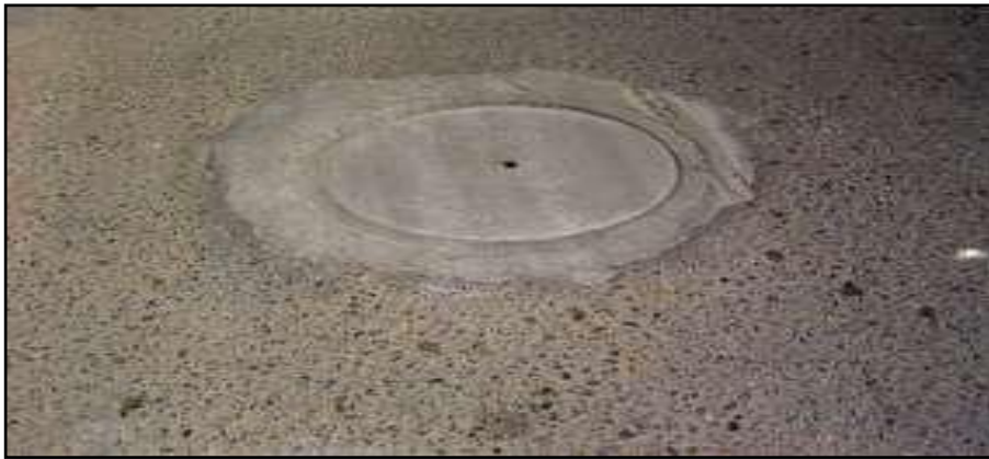
Figura 16. Parcheo de cortes utilitarios
