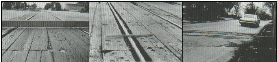
Figura 19. Cruce de vía férrea
