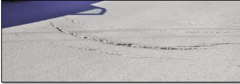
Figura 22. Grieta parabólica
