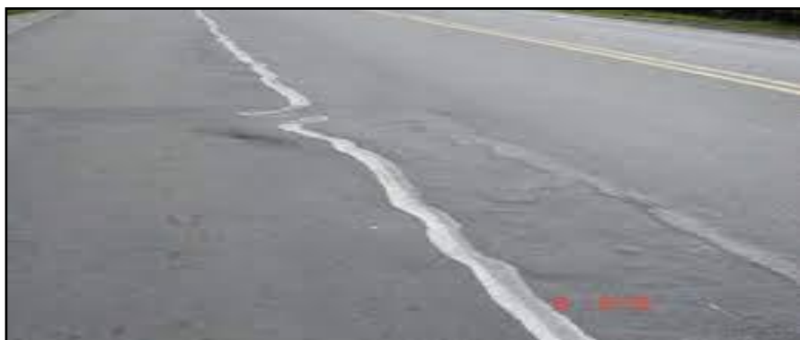
Figura 21. Desplazamiento
