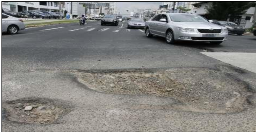
Figura 18. Huevo en el pavimento (baches)
