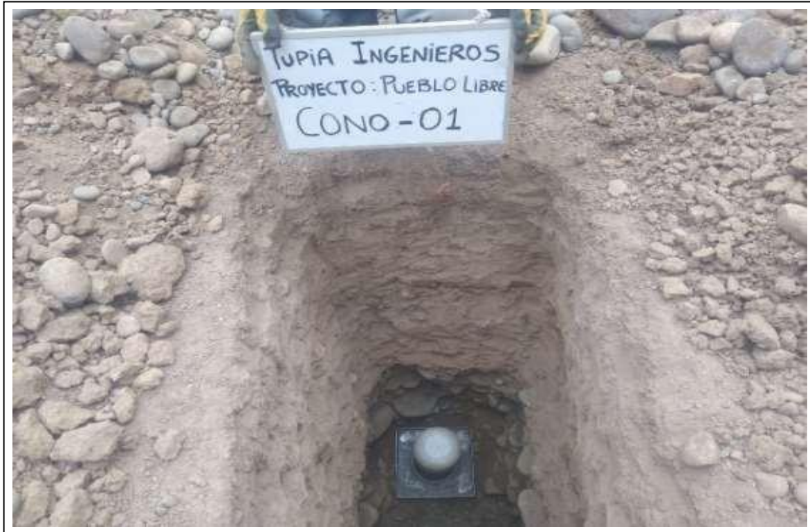
Figura 3.2. Ensayo de cono de arena, en el área de estudio
