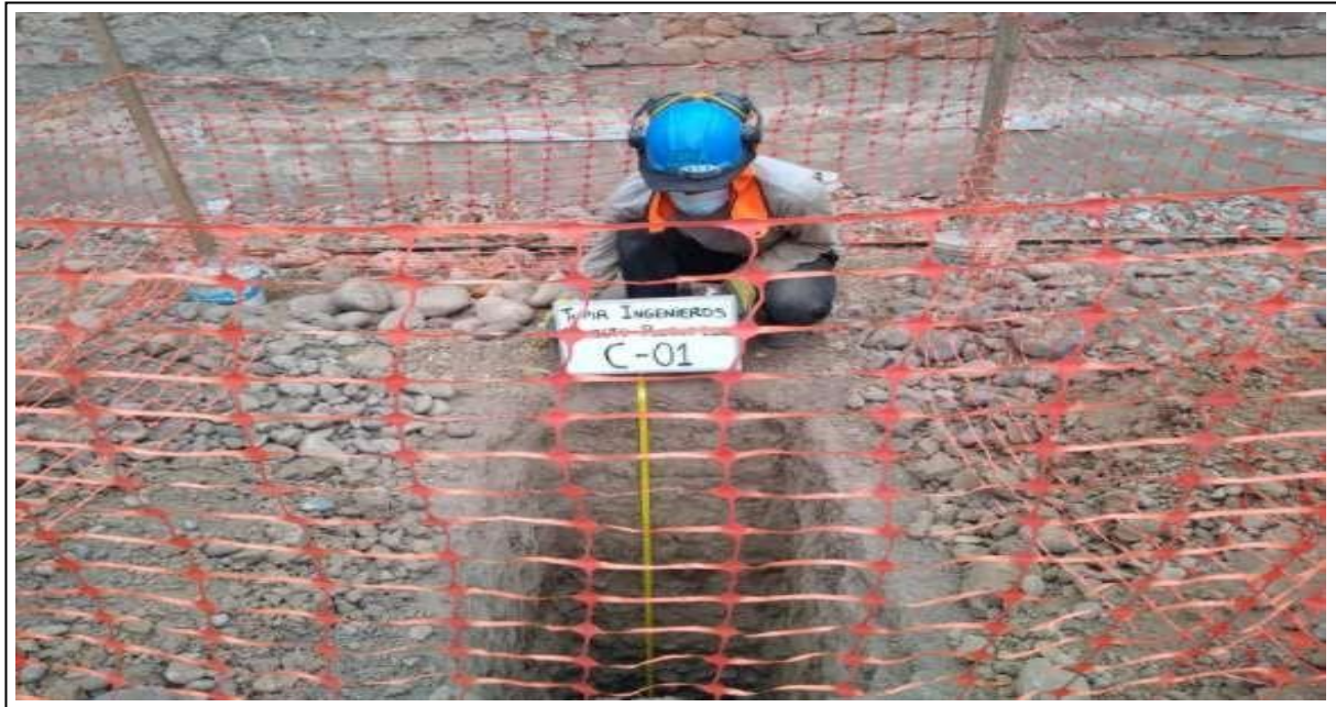
Figura 3.1. Excavación de calicatas en el área de estudio, Distrito de Pueblo Libre
