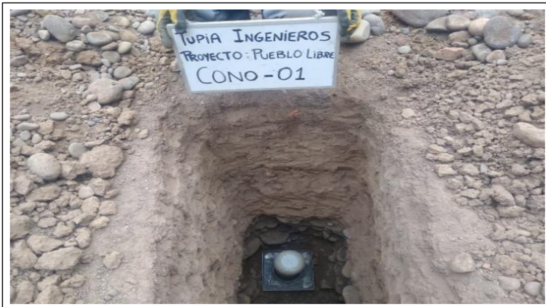
Figura 21. Ensayo de cono de arena
