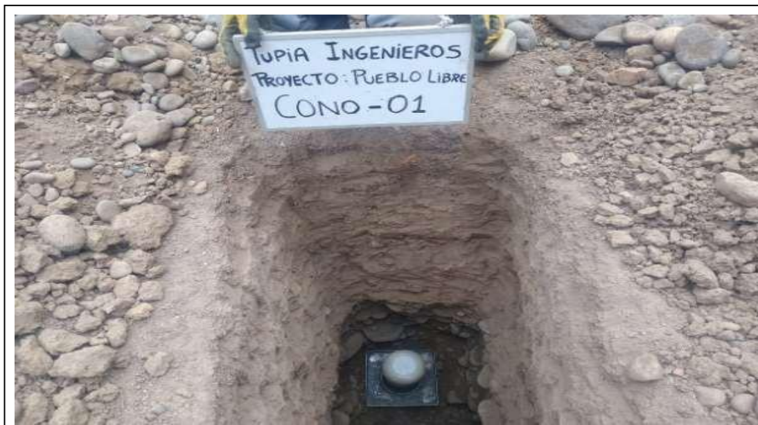
Foto N°4: Ensayo de cono de arena CONO-01, Prof. De 2.00 m en la calicata C-01, se realiza para obtener la densidad del suelo encontrado.
