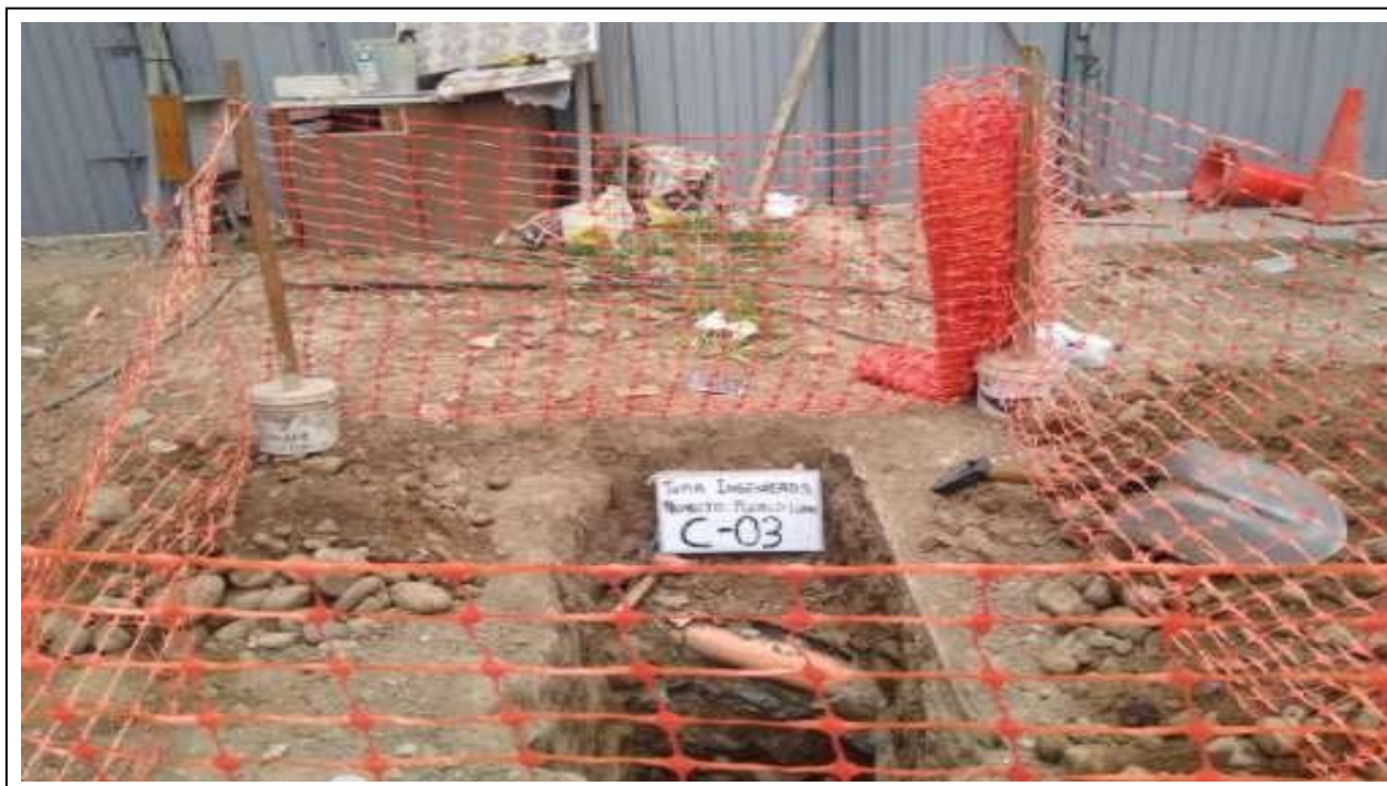
Foto N°3: Calicata C-03, con Prof. De 4.00 m, se encontró un estrato de 0.00 – 1.00 m suelo de relleno conformado por arena mal gradada y de 1.00 m a más es un suelo conformado por grava bien graduada (GW) con presencia de canto rodado.
