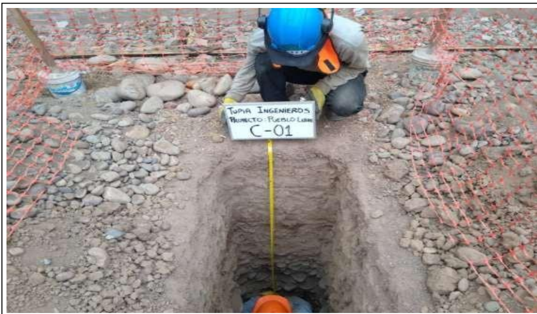
Foto N°1: Calicata C-01, con Prof. De 4.0 m, se encontró un estrato de 0.00 – 1.10 m suelo de relleno conformado por arena mal graduada y de 1.10 m a más es un suelo conformado por grava bien graduada (GW) con presencia de canto rodado.
