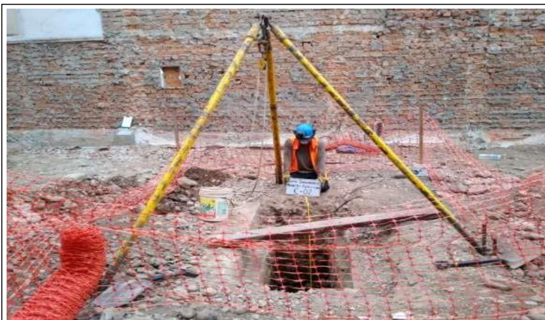
Foto N°2: Calicata C-02, con Prof. De 7.00 m, se encontró un estrato de 0.00 – 1.20 m suelo de relleno conformado por arena limosa y de 1.20 m a más es un suelo conformado por grava bien graduada (GW) con presencia de canto rodado.
