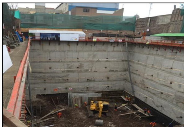
Figura 8. se visualiza los muros anclados por anillos
