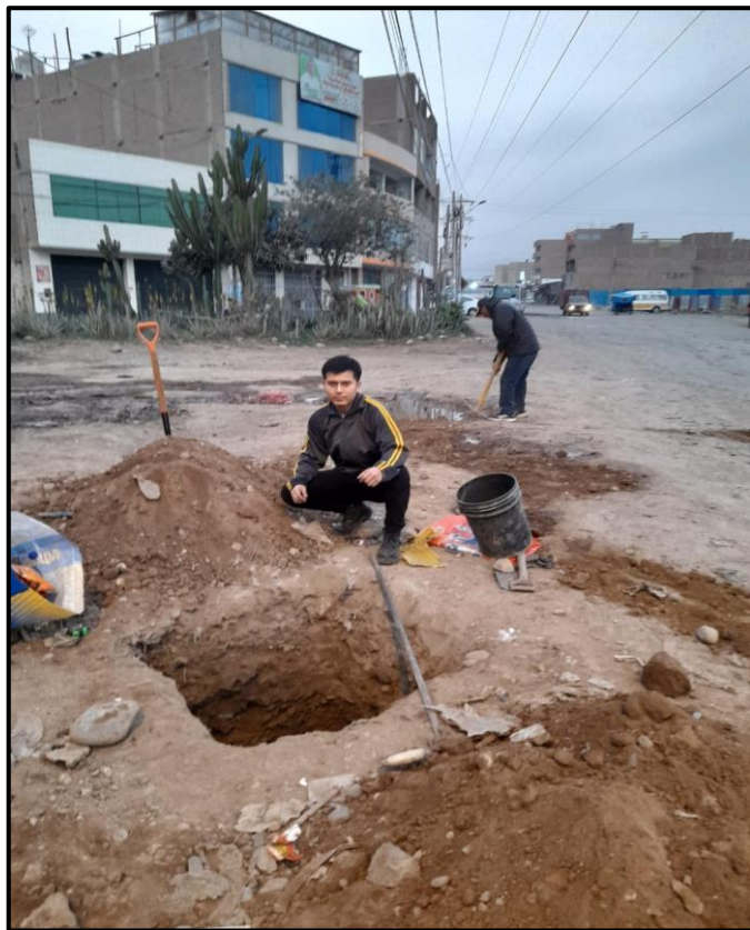
Fotografía 9: Culminación de calicata.
