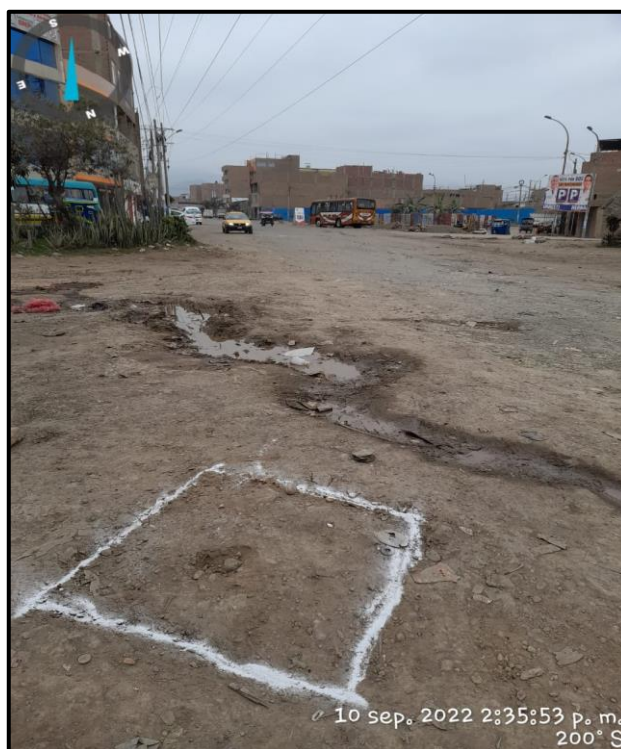
Fotografía 6: Trazo de calicata 1.20m x 1.20m.
