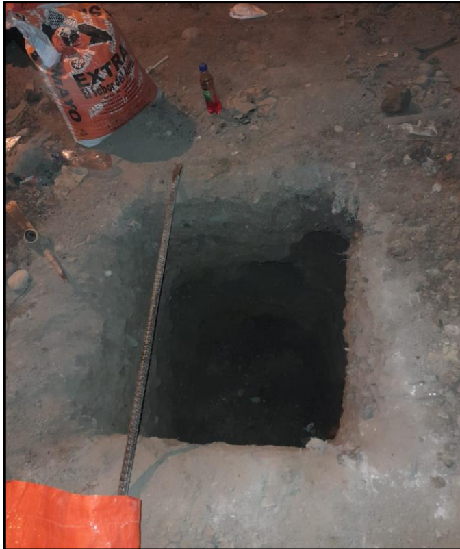
Fotografía 8: Profundidad de calicata a 1.70m.
