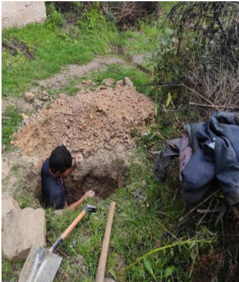
CALICATA 2 (tierra arcillosa)
