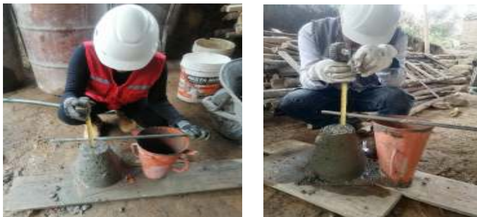
Figura 18. Ensayo de asentamiento y consistencia del co
