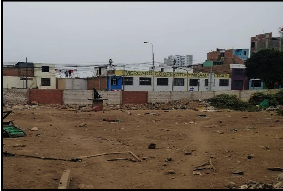
Fotografía N° 01: Terreno del proyecto – Av. Los Insurgente 102
