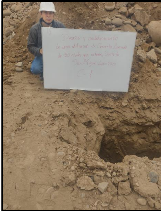
Fotografía N° 05: Estudio de Suelos Calicata C-1
