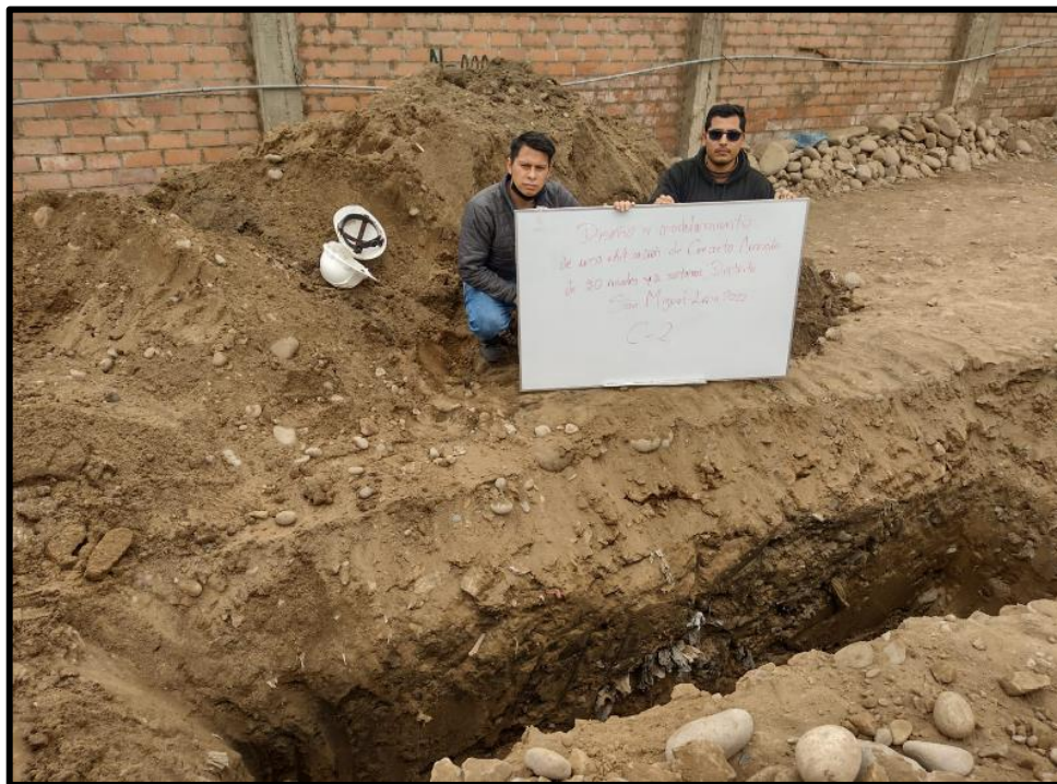
Fotografía N° 06: Estudio de Suelos Calicata C-2
