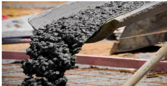
Figura 1. Mezcla de concreto
