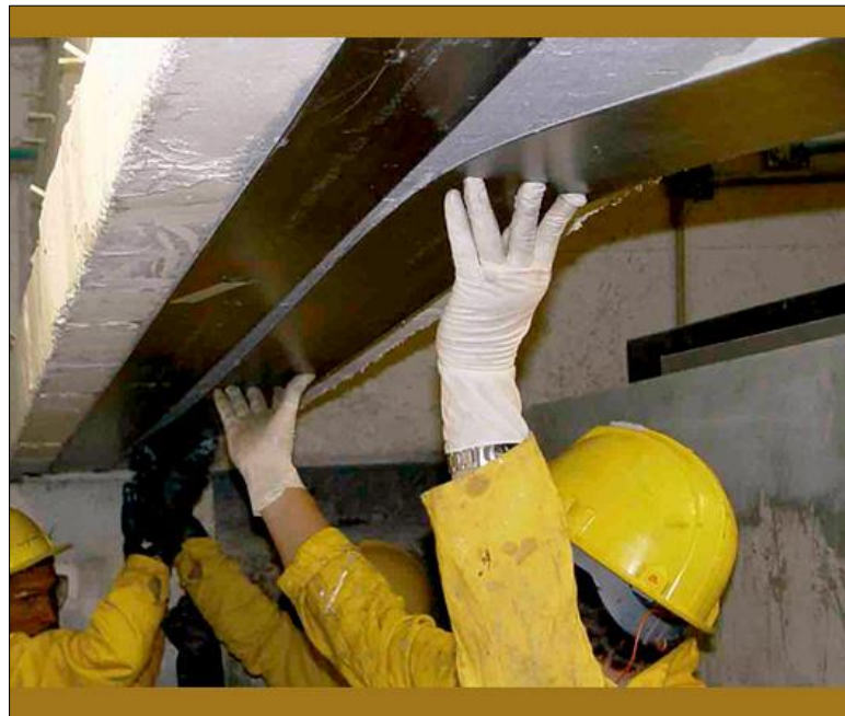
Figura 5: Refuerzo con fibras de carbono en vigas de concreto.
