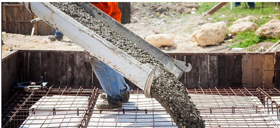
Figura 1: Concreto en estado fresco
