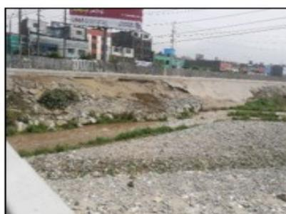
Se observa el muro de contención con fallas en su estructura el cual se ha erosionado por las crecidas del río Rímac.
