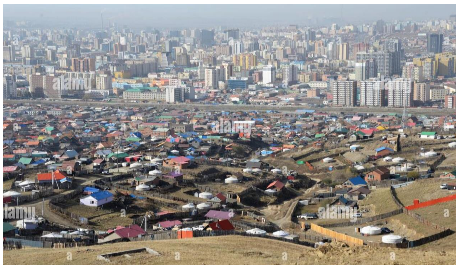
Deficiencia en el borde urbano
