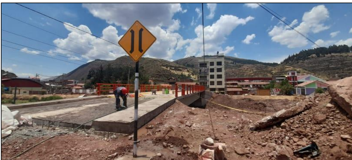
Fotografía 08 y 09: Etapa final de construcción del puente carrozable Saylla – Cusco noviembre 2022.
