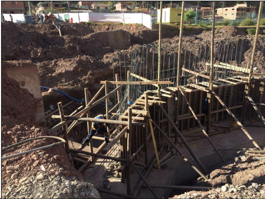
Fotografía 03: Ejecución de construcción del puente carrozable Savlla – Cusco octubre
