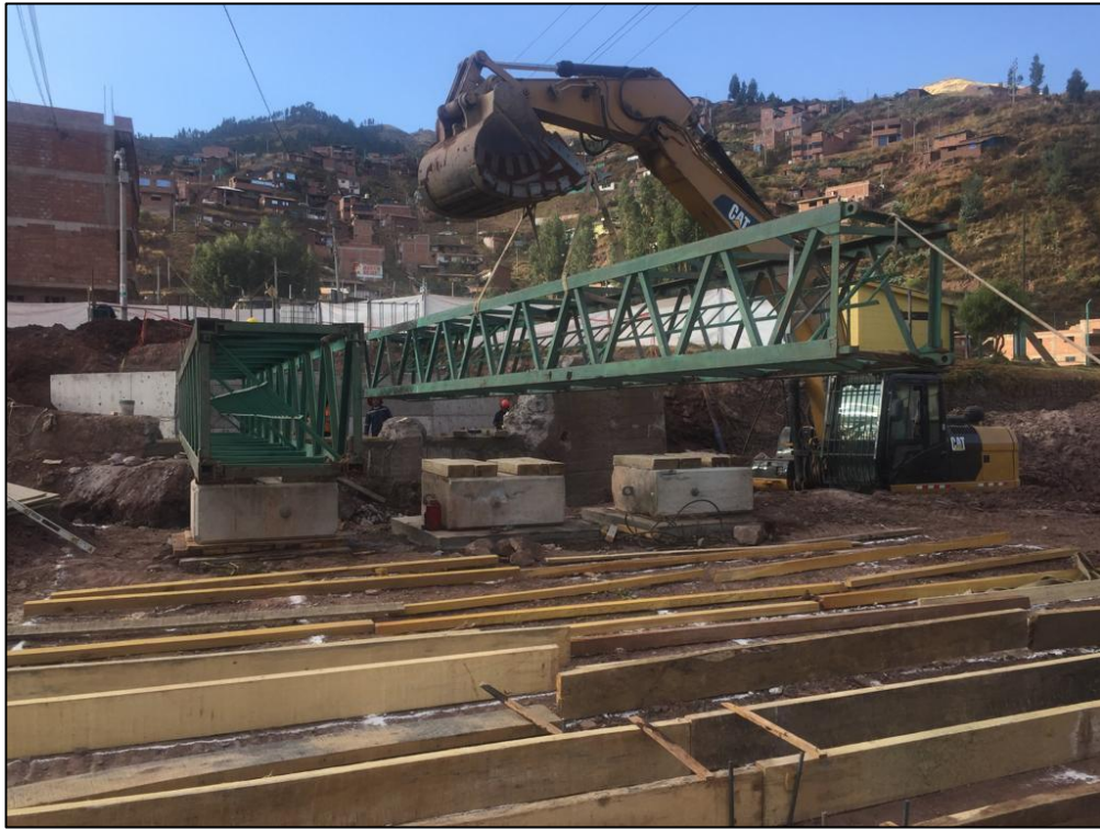
Fotografía 05: Ejecución de construcción del puente carrozable Saylla – Cusco octubre 2022.
