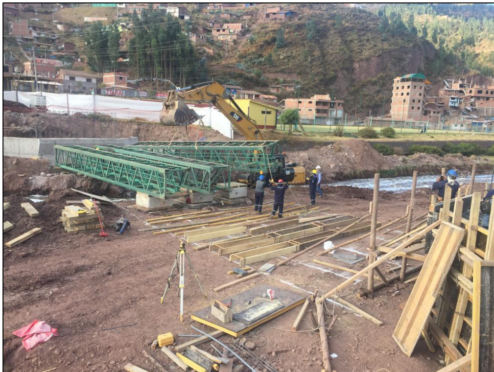
Fotografía 06: Ejecución de construcción del puente carrozable Saylla – Cusco octubre 2022.
