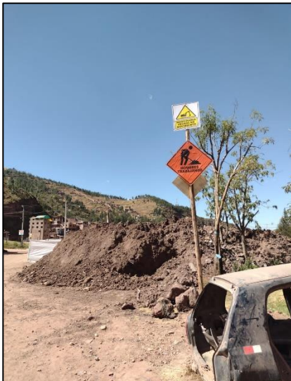
Medida de mitigación – áreas de remoción en obra
