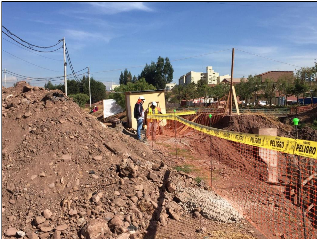
Fotografía 04: Ejecución de construcción del puente carrozable Saylla – Cusco octubre 2022.
