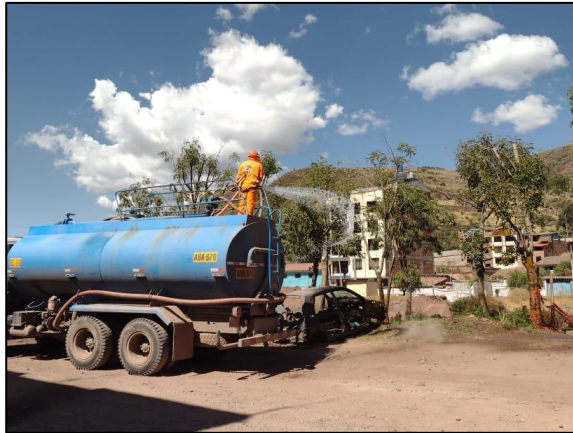
Medida de mitigación - Humectación de área de trabajo
