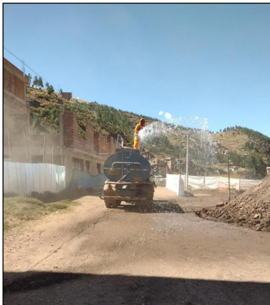
Medida de mitigación - Humectación de área de trabajo
