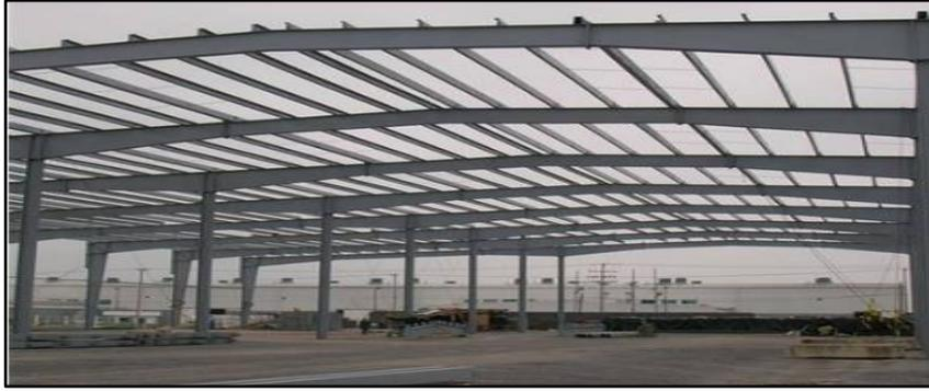
*Figura 4. Vigas estructurales.*
