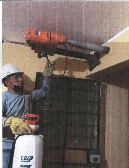
EXTRACCIÓN DE LA DIAMANTINA V-1 DE LA TESIS *"Análisis sísmico comparativo de reforzamientos y disipadores para una vivienda multifamiliar de seis pisos, distrito de Cercado de Lima-2022"*– Ubicado en Av. Prolongación Arica 1760, Cercado de Lima, Lima, Perú
