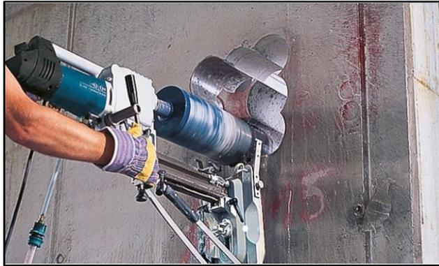
*Figura 12.* Ensayo de diamantina
