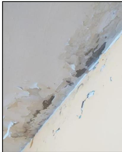
*Figura 10.* Losas aligeradas de 17 cm con fisuras.
