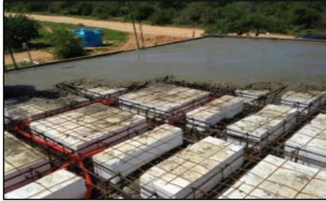
*Figura 5.* Losa aligerada.
