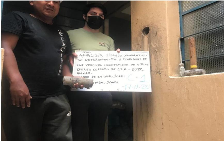
Figura 22. Extracción del testigo diamantino C-1
