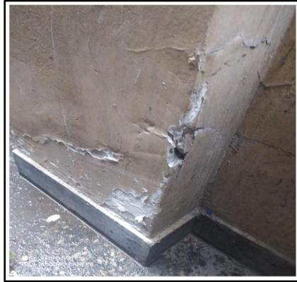
*Figura 9.* Columnas de concreto de 35cm\*35cm con fisuras y cangrejeras.
