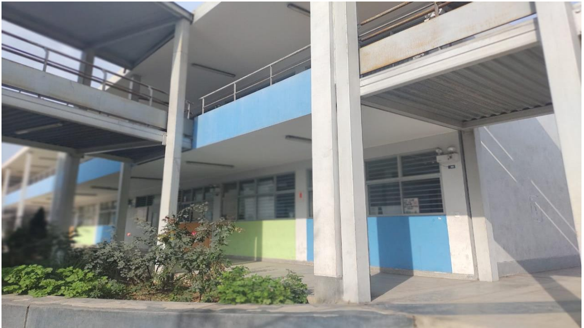
Figura N°3: Pabellón “G” del Colegio José Granda
