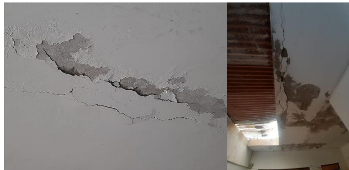
Figura 02. Losa aligerada existente
