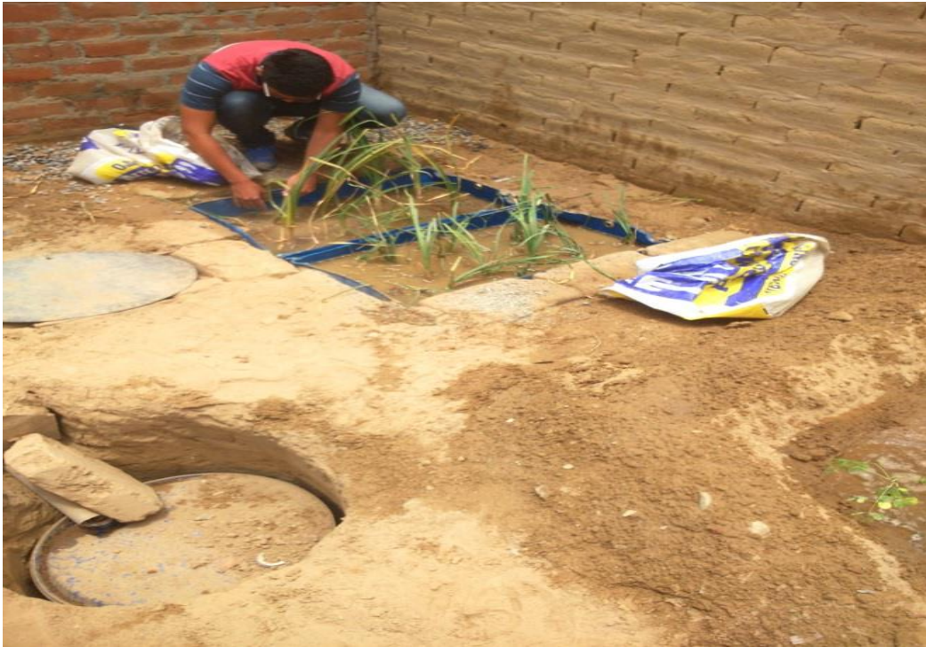
FIGURA N°21 Se observa el monitoreo realizado por mi persona para el debido funcionamiento del biofiltro con eneas durante los días siguientes, así también se puede ver los cilindros donde se almacenara el agua residual tratada por el biofiltro con eneas para su utilización de áreas verdes.
