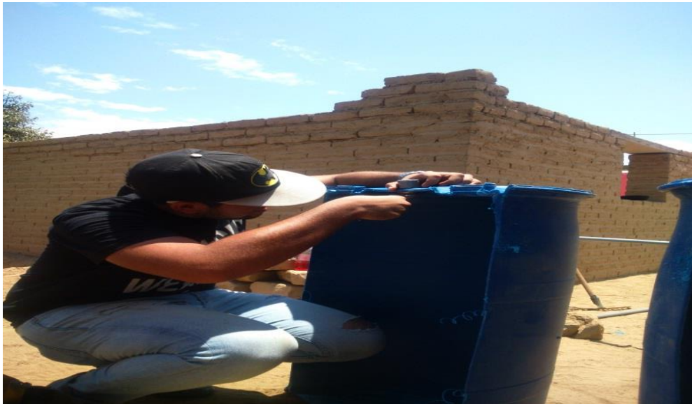
FIGURA N°19 Se observa dos entradas en la parte superior por las cuales ingresará el agua residual sin tratar y así mismo dos salidas por la cual saldrá el agua residual tratada, es una parte de lo que será el biofiltro con eneas para su debida instalación en el terreno.
