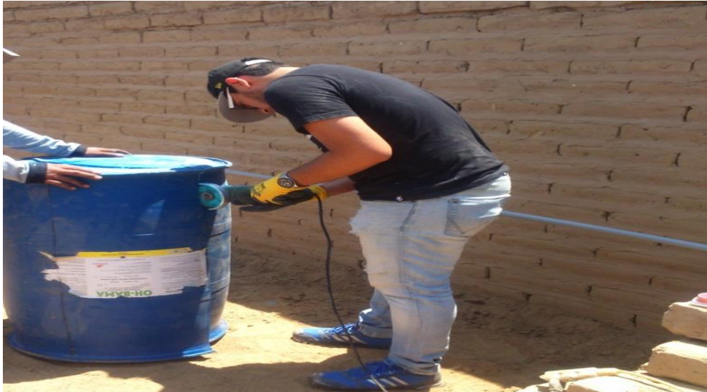
FIGURA N°17 Se observa el corte de los cilindros los cuales serán dos recipientes que serán la base del biofiltro con eneas, para luego implementar los siguientes componentes.
